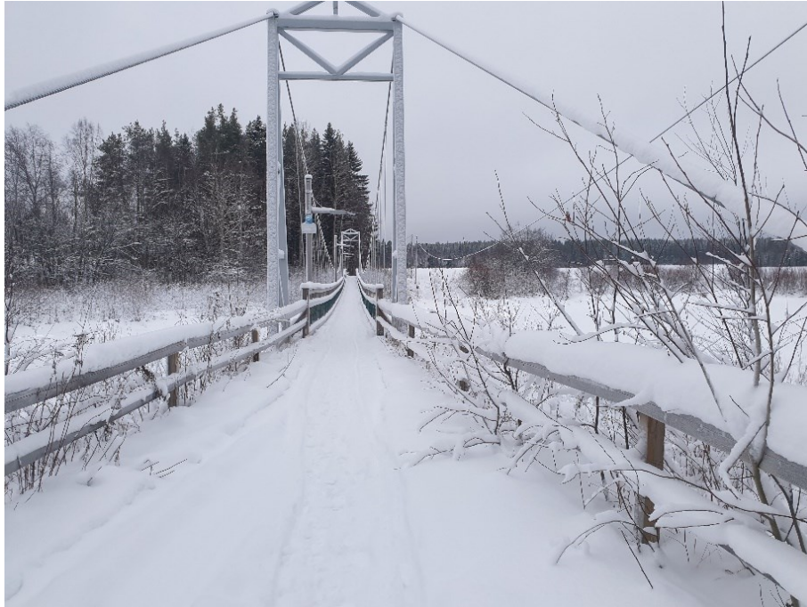
Hemminkoskella sijaitseva Vekalan riippusilta. Hemminkosken yli tavattiin ennen Leader-rahoituksella rakennettua kiinteää riippusiltaa pystyttää keväisin tilapäinen, nk. renkkusilta. Renkkusiltoja mainitaan olleen joen yli vilkkaimpina vuosina alueella useampia. Renkkusillat yleistyvät 1900-luvun vaihteessa Siikajokilaaksossa. Kuva: Henna Tuomiranta tammikuu 2022.
