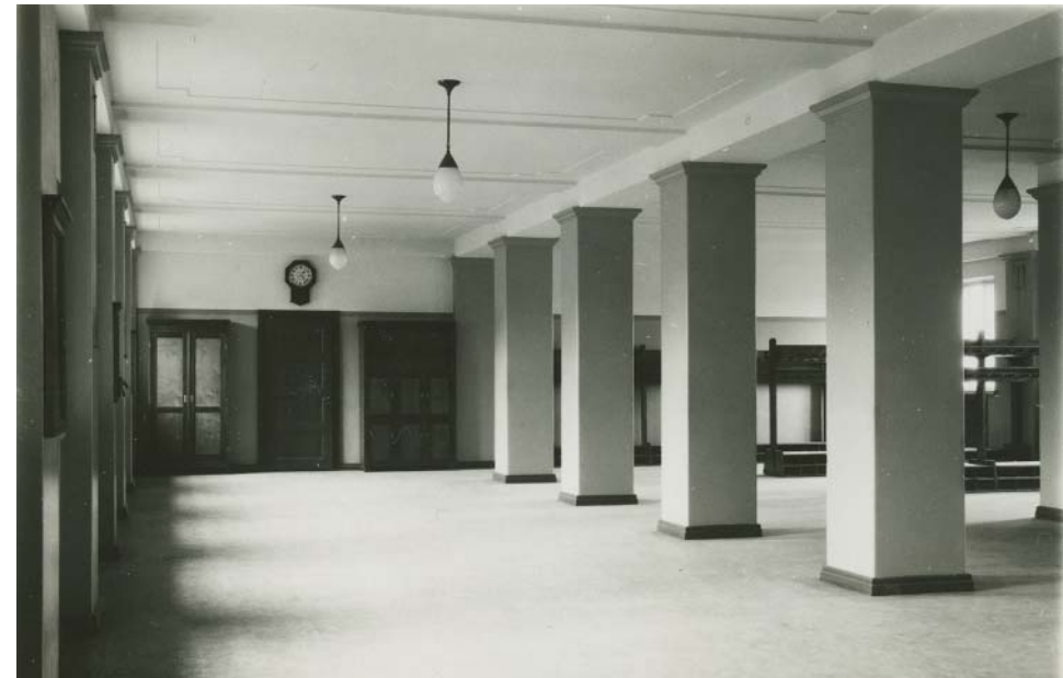
Kuva 62. Pian rakennuksen valmistumisen jälkeen otetussa kuvassa vanhan koulutalon ala-aula on alkuperäisessä asussaan. Pilarit, ovet ja listat ovat tummia ja seinien yläosa sekä katto koristesyvenyksineen vaaleita. Seinän väripintojen rajalla kiertää juokseva koira -ornamentti.
