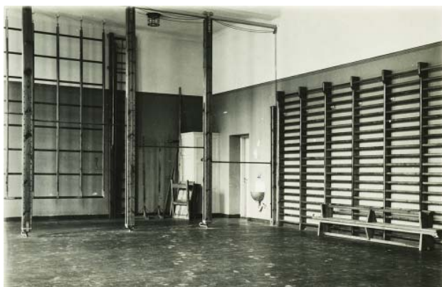
Kuva 69. Alimmassa kuvassa alkuperäisessä asussaan näkyvään poikien voimistelusaliiin toteutettiin 1990-luvun alussa kirjasto ja tutkimusluokka sekä työtiloja. Yläkuvassa näkymä kirjastoon.
