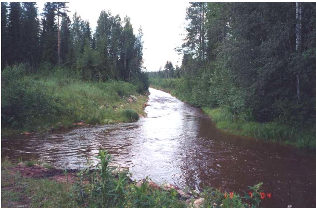
Kuva 8. Perattua ja kanavoitua aluetta Muhoarjoen keskiosalla Leppijokisuulla. Kuvassa keskellä 90-luvulla rakennettu uoman oikaisu (n. 1 km). Joen vanhan, luonnontilaisen uoman niska kuvassa vasemmalla.
