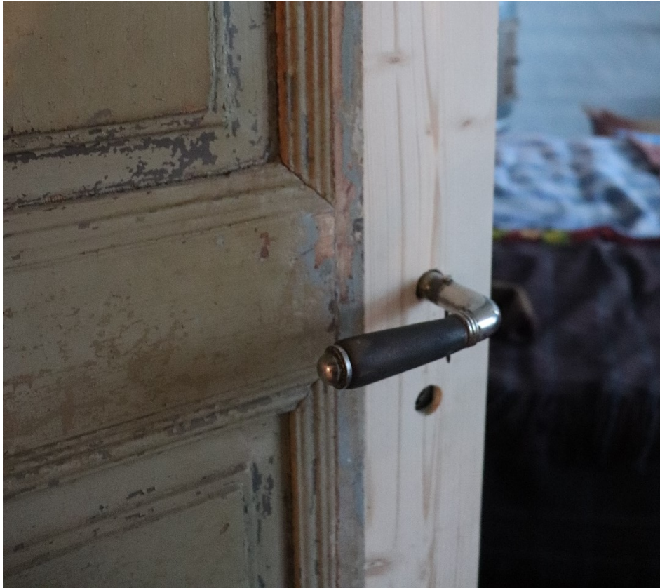
Vanha ovi haluttiin säilyttää, joten se korjattiin uudella laudanpätkällä C-talossa. Kuvaaja: Auni Tuovinen.
