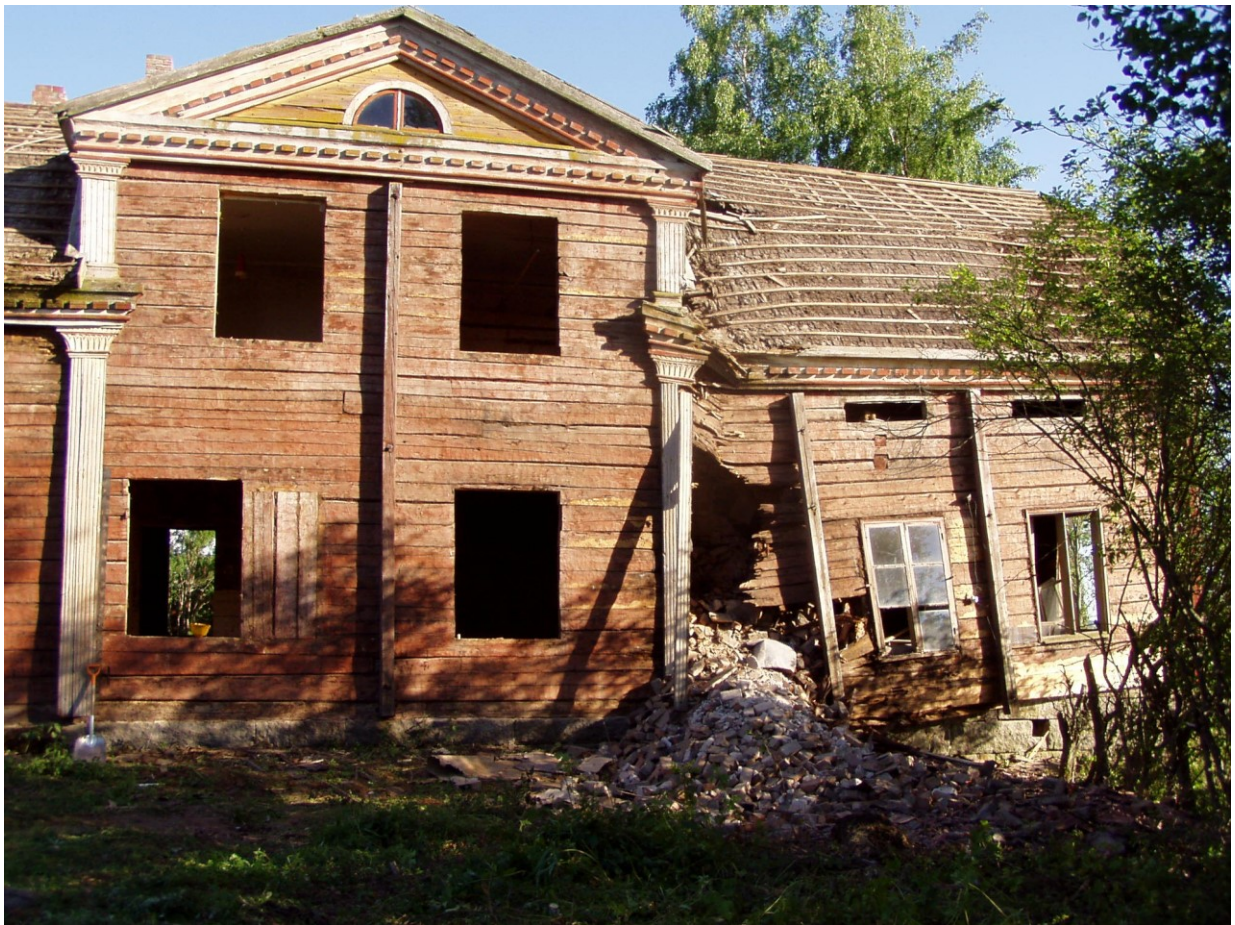
A-talo ennen siirtoa. Takan muuri oli sortunut ulos asti. Kuva: A-talon kotialbumi.
