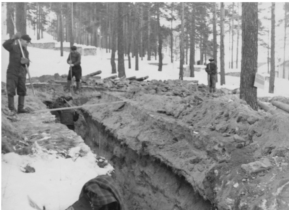
Kuva 7 Miehet kaivamassa sirpalesuojia Jyväskylän Harjulla. Valokuvaaja Antti Pänkäläinen, 1939–1940, Keski-Suomen museo.
