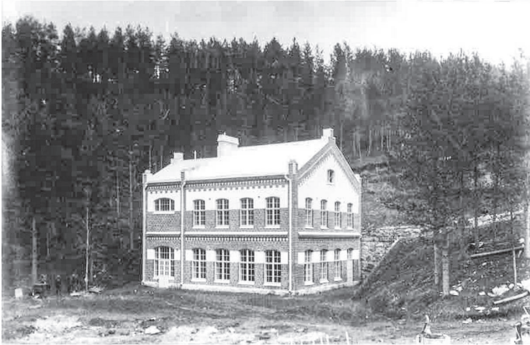
Kuva 4. Hämeenlinnan vesijohtolaitoksen vuonna 1910 valmistunut kaksikerroksinen konehuone. Sen on ilmeisesti suunnitellut rakennusmestari Otto Tolonen. Rakennus oli pystyssä vielä syksyllä 2019. Etualalla oikealla näkyy toisen porakaivon yläosa. Kuvasta käy hyvin ilmi vedenottoalueen pinnanmuodostus. Hämeenlinnan kaupunginmuseon kokoelmat.
