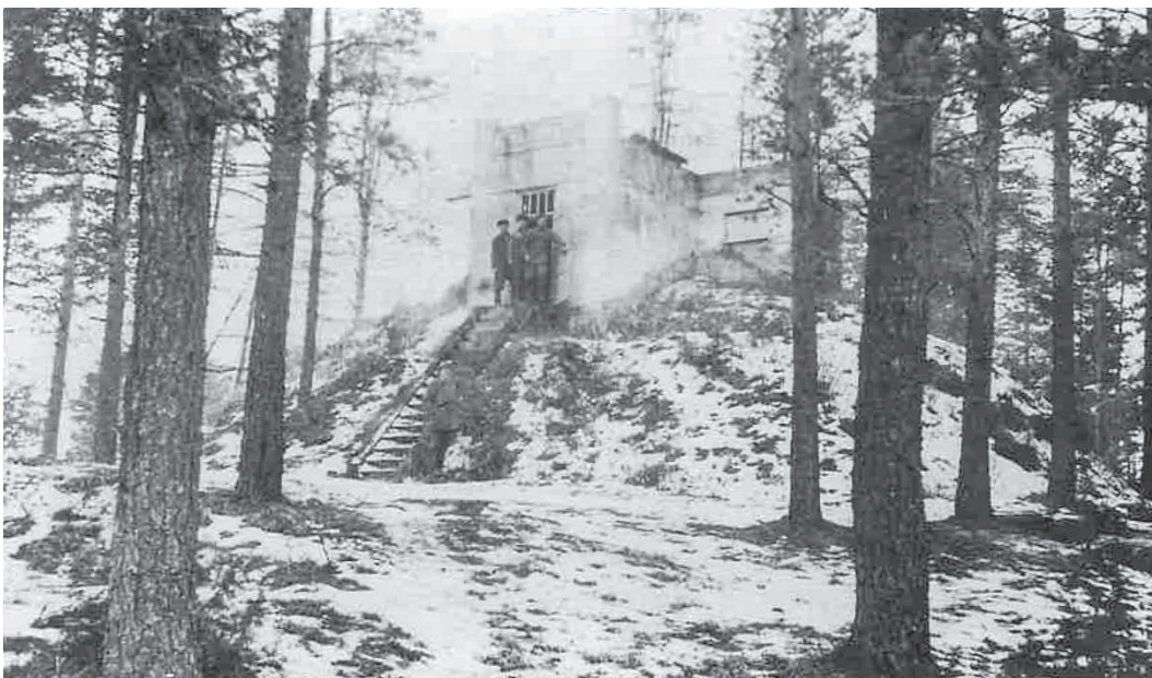
Kuva 5. Vuonna 1910 valmistunut betoninen vesisäiliö vuonna 1934. Riittävän vedenpaineen turvaamiseksi säiliötä ei kaivettu maahan, vaan se peitettiin soralla. Insinööri Jalmari Castrénin suunnittelema kaksiosainen vesisäiliö oli aikanaan hyvin edistyksellinen, siinä oli jopa sähköinen vedenkorkeuden osoittaja, jonka mittaristo oli asennettu sekä konehuoneeseen että koneenkäyttäjän asuntoon. Hämeenlinnan kaupunginmuseon kokoelmat.
