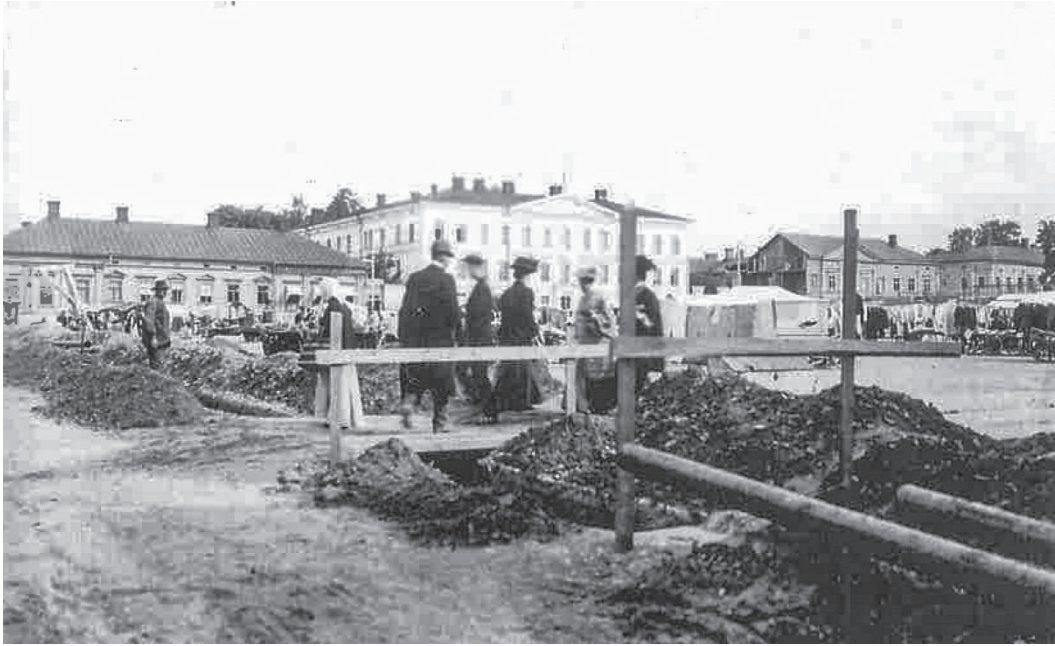
Kuva 7. Vesijohto- ja likaviemäriputken kaivanto on saavuttanut syksyllä 1910 Ison torin (nykyinen Hämeenlinnan tori), tarkemmin sanottuna Läntisen Linnankadun (nykyinen Sibeliuksenkatu). Etualalla kaksi 125 mm:n Mannesmann-vesiputkea. Taustalla näkyvä vaalea kivrakennus on maaherran residenssi, sittemmin lääninhallitus. Sen viereiselle tyhjälle tontille rakennetaan Rytkösen kirjakauppaa. Hämeenlinnan kaupunginmuseon kokoelmat.
