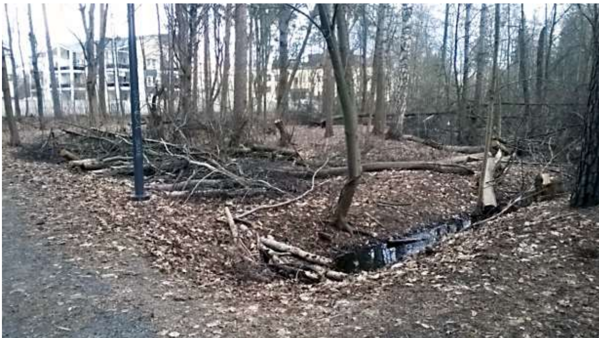
Tulvavesipoistonoja G-rakennuksen vieressä.
