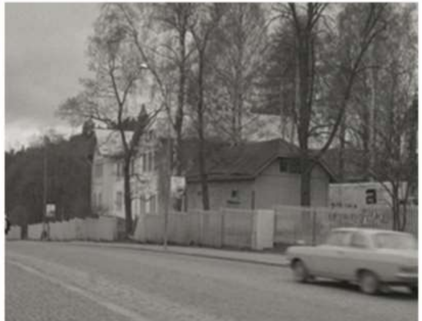
Kuva 1970-luvun alusta, ennen rakennuksen purkua, JYM
