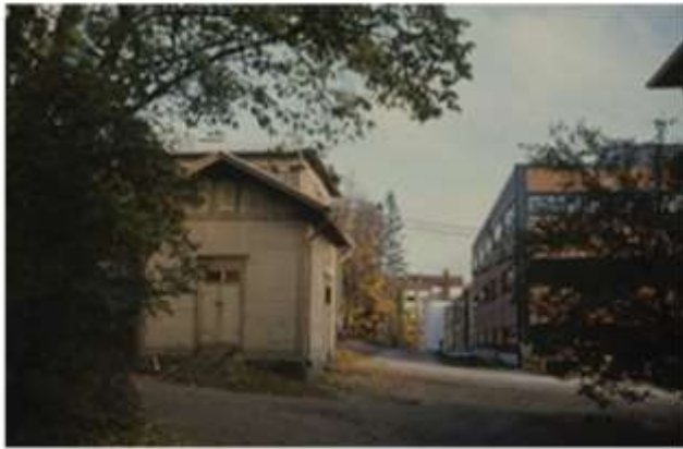
Kuva 1973-74, ennen rakennuksen purkua, JYM
