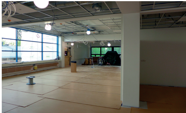
Kolmannen kerroksen alakattotyöt ja talotekniikan asennukset.
