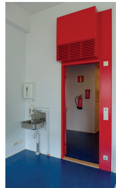
Opetustila 312: Oven yläpuolella ääniloukku-rakenteella toteutettu ilmanvaihdon virtausaukko. Säleikkö on puuta ja kotelo lastulevyä. Oven vieressä vesipiste.
