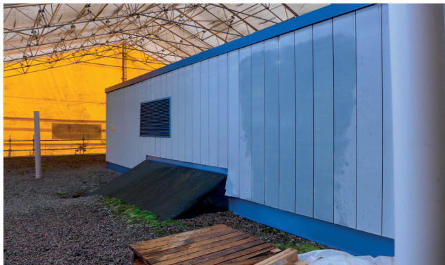
Kuva ennen purkuja. Vanha ulkoseinästä konehuoneeseen johtanut raitisilmakanava on ollut pitkään pois käytöstä.
