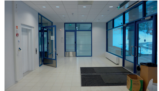
Tuulikaappi. Seinällä olleen taideteoksen paikalle on puhkaistu uusi ovi uuteen neuvotteluhuoneeseen.
