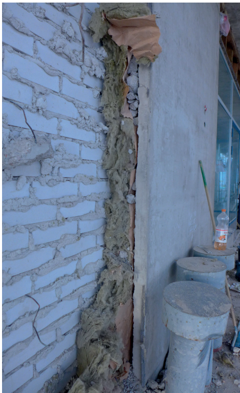
Koillissivulla elementtien purkua. Niiden paikalle tuli korkeat ikkunat.
