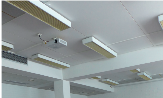
Luentosalin katon maalattua kovalevyä. Palkin toisella puolella laskettu alakatto.
