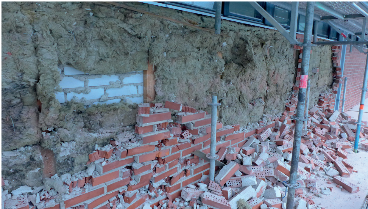
Ulkoseinien purkutyöt ja kaikki vanhat kerrokset näkyvissä: ulkomuuraus, mineraalivilla, ikkunoiden puiset tukirakenteet ja sisäpuolinen muuraus.
