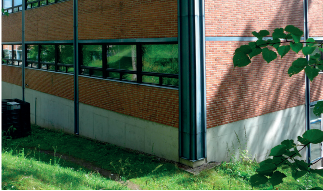
Studion betonirakenteiset maanpinnan yläpuoliset seinät ennen peruskorjausta.
