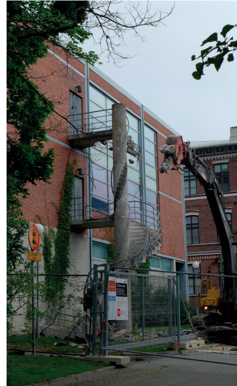
Portaiden purkaminen oli peruskorjauksen ensimmäisiä työvaiheita.
