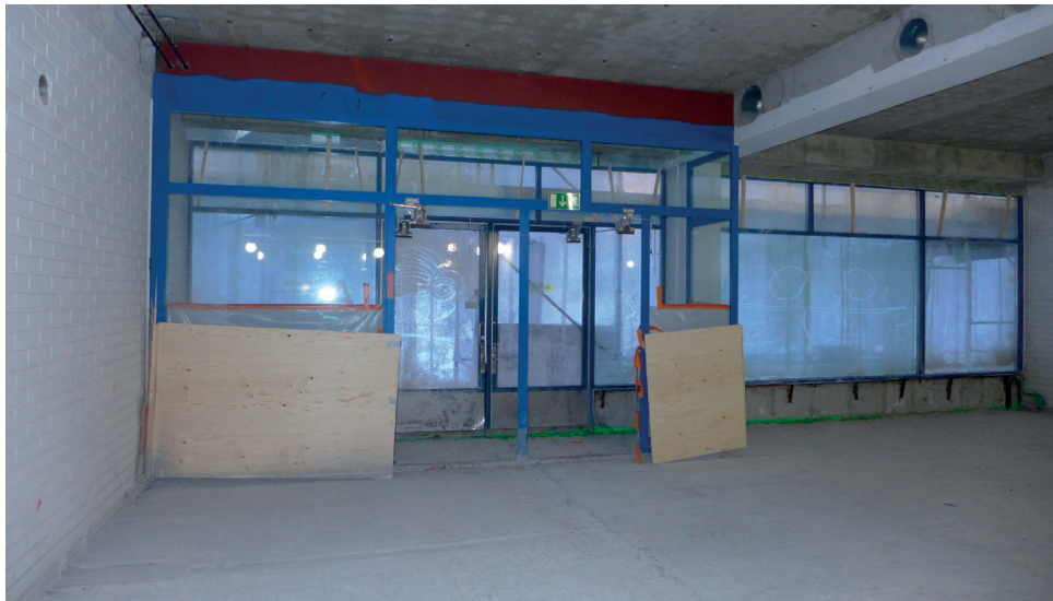
Pieni metallirunkoinen tuulikaappi rakennuksen lounaanpuoleisen sisäänkäynnin kohdalla.
