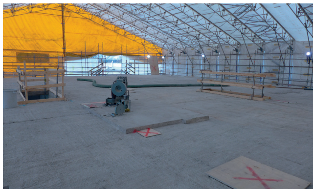
Purkutöitä katolla ovat valmistuneet. Keskellä kuvaa se, mitä hissikonehuoneesta on jäljellä.
