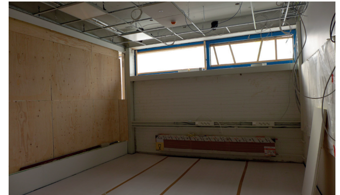
Kaakonpuoleisella seinällä ikkunoiden alapuolelle asennettu sokkelielementtien kiinnityspalkki.
