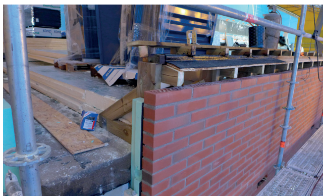
Räystään uudet puurakenteet ja bitumikermin kiinnitys painon avulla.
