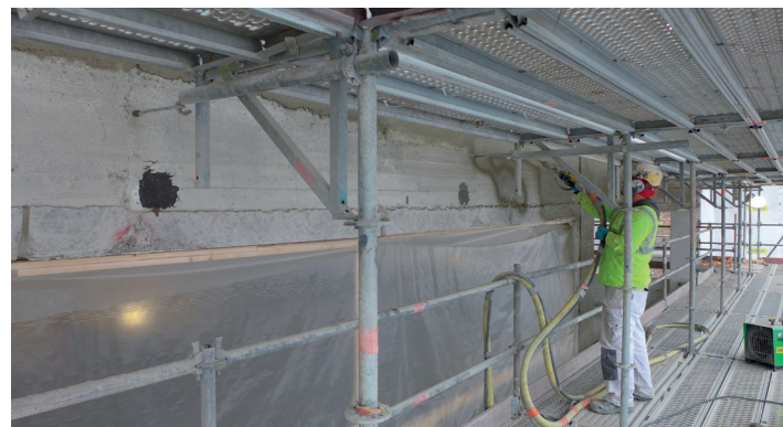
Saapaspalkkien leuat on sahattu ja pinta hiekkapuhallettu. Pinnalle ruiskutetaan tasoitekerrosta.
