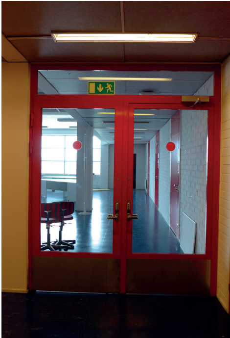
Vanhat metallirunkoiset pari-ovet kolmannen kerroksen entiseen kirjastoon.
