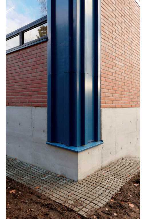
Valmiin kulmapilarin pellityksen alareunaa on nostettu aiempaan verrattuna.
