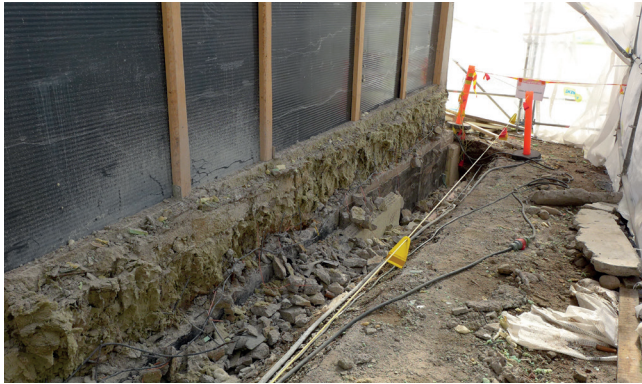
Sokkelihalkaisun purkaminen: betoninen ulkokuori purettu, villaeriste näkyvillä.
