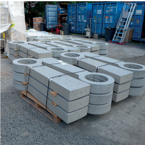
Uudet porraselementit ovat saapuneet työmaalle.
