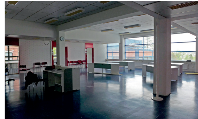
Tila kuvattuna ennen peruskorjausta suuren ikkunaseinän suuntaan.
