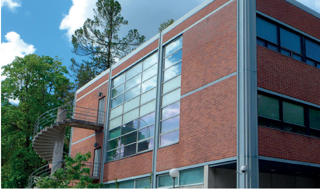
Kaakkoissivun lasiseinä ja valkoiksi haalistuneet, alkujaan siniset levyt lankalasin takana.
