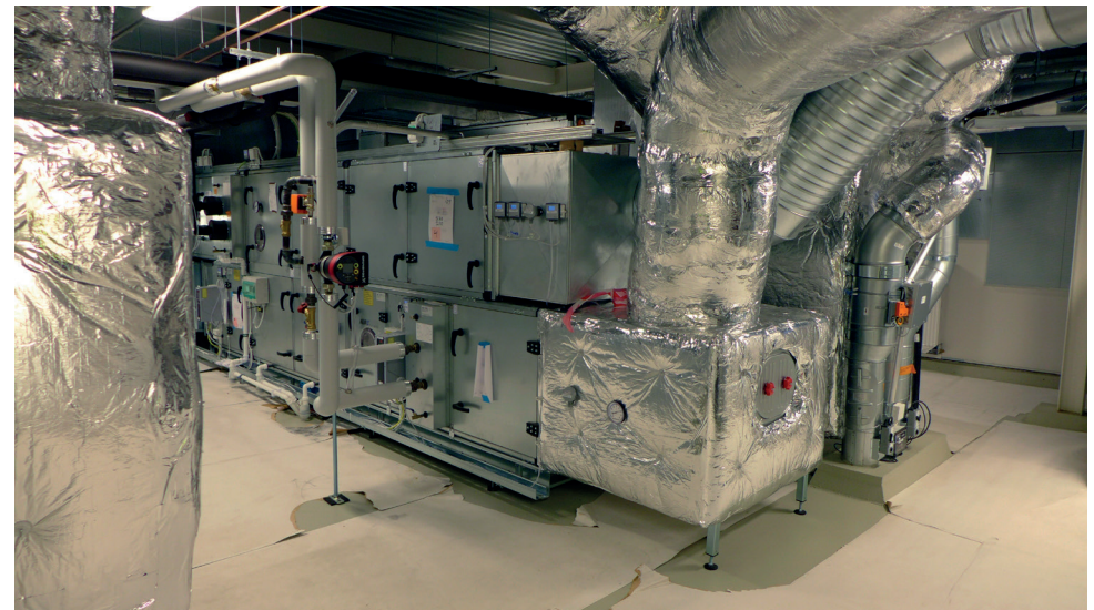
Uusi konehuone korjauksen lähestyessä loppua.
