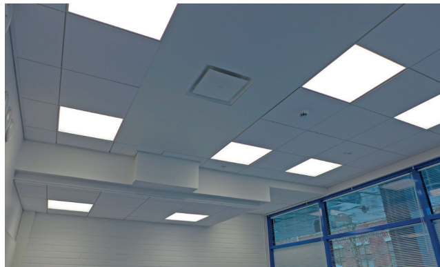
Entisen luentosalin paikalle tulleen työtilan katto. Laskettu katto ei jatku ikkunaseinäksi muuttuneeseen seinään asti.
