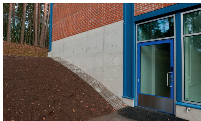
Sokkelin vieressä oleva kiveys. Pihan asfaltointi yltää tällä sivulla rakennukseen asti.
