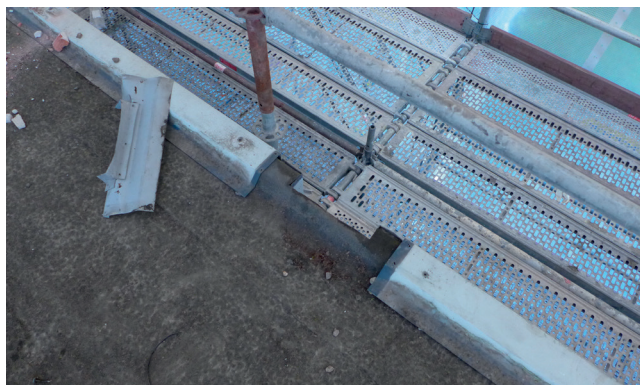
Sora on poistettu. Matala räystäs pilarin kohdalta kuvattuna (vrt. s. 33 uusi räystäspellitys).
