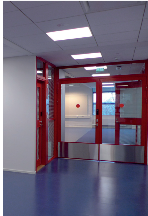
Uusi metallilasiovi ja -seinä käytävän 339 ja työtilojen (sama tila kuin ed. kuvassa) välillä.
