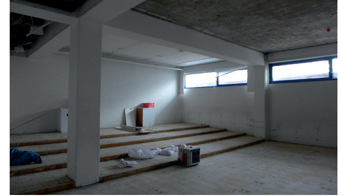
Suuren luentosalin kiinteät kalusteet ja pintamateriaalit on purettu.
