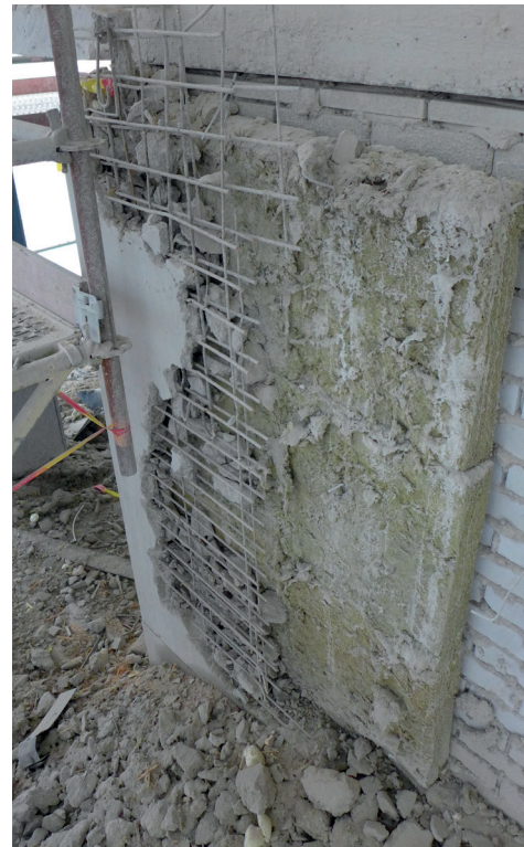
Elementin purkua luoteenpuoleisella sivulla.
