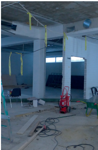
Aulan ja luentosalien välistä on purettu osa väliseinistä.
