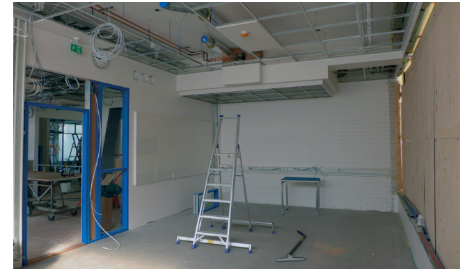
Uusia tekniikka-asennuksia ja alakatot.
