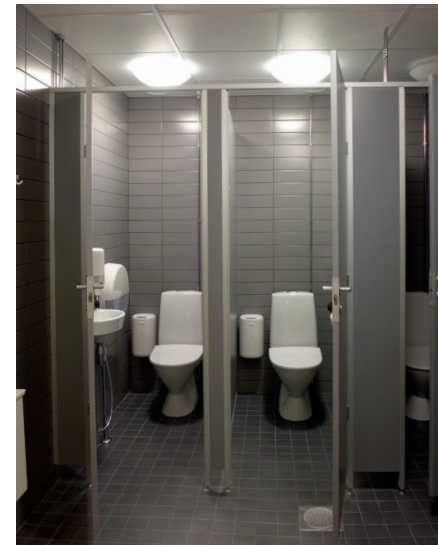
Naisten wc-tilat korjauksen jälkeen.
