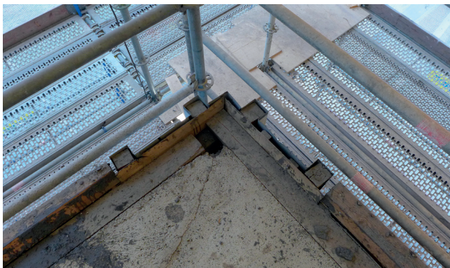
Kulman pilarin vanhat puurakenteet näkyvät hyvin katolta otetussa kuvassa.
