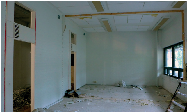
Alkuperäinen puurunkoinen, mineraalivillatäytteen ja levy-pintainen väliseinä on purettu pois.
