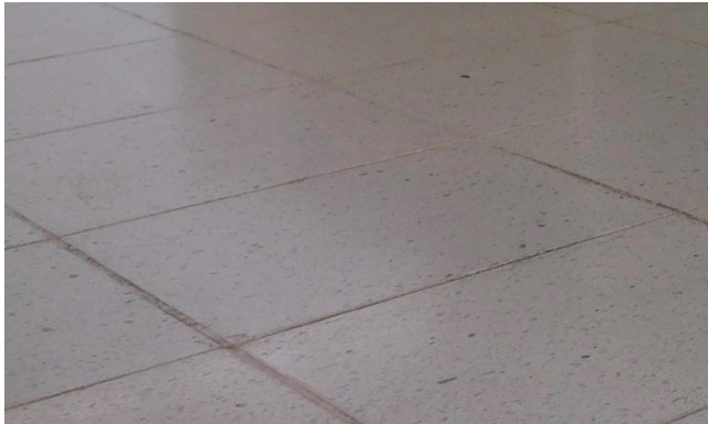
Ensimmäisen kerroksen aulatilän alkuperäinen mosaiikkibetonilaatoitus.
