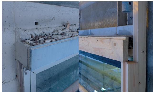
Ikkunan yläpuolisen betoniotsan pellitys sekä otsan korvannut uusi puurakenne.
