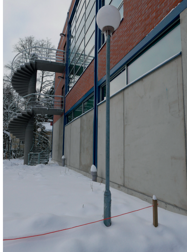
Pihan vanhat pylvävalaisimet asennettiin korjauksen jälkeen takaisin paikoilleen.
