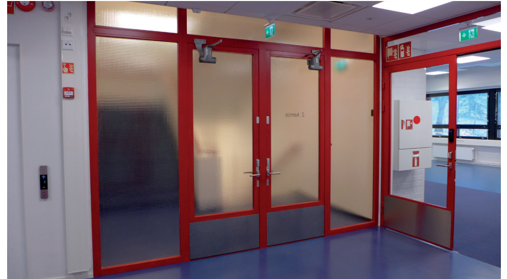
Vanhat portaikon ovet ja lasiseinät korjauksen jälkeen ja vieressä uusi ovi.
