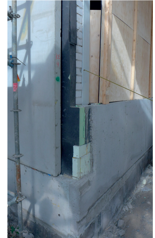
Itäkulmassa näkyy elementtiseinän rakenne ennen kulmaelementin asentamista. Kuvaa-ja: Riikka Mäkipelkola
