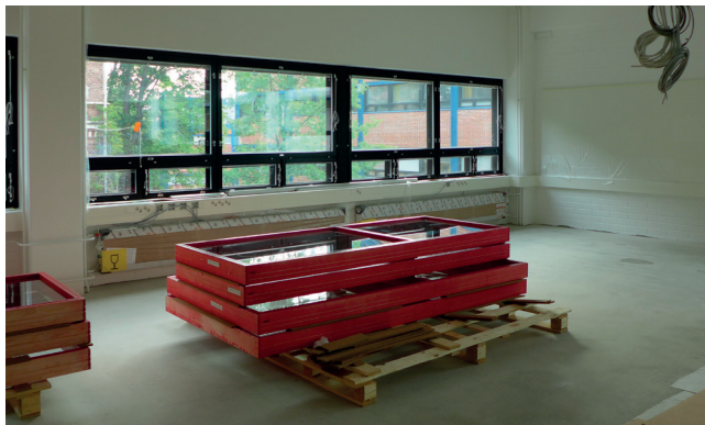
Uusia ovi- ja ikkunaelementtejä on saapunut työmaalle.
