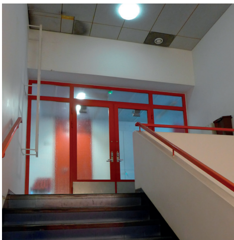
Kolmannen kerroksen tasanne ennen peruskorjausta.
