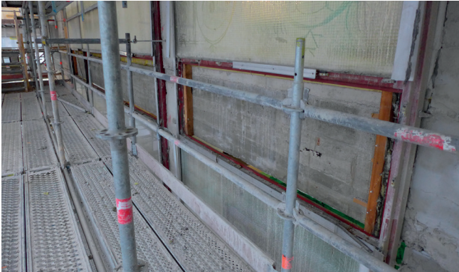
Kaakkoissivun lasiseinän välipohjan kohdalle osuivien lankalaserivien purkaminen.
