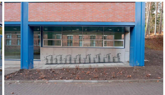
Uusi sokkeli ja ikkunoiden alapuolinen seinärakenne.
