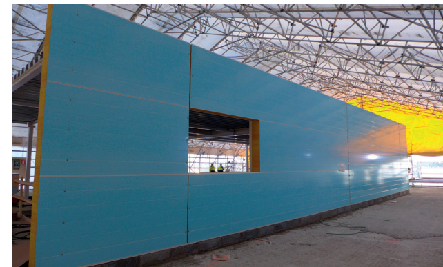
Seinärakenteiden asentaminen. Katon profiilipelti on jo paikallaan.
