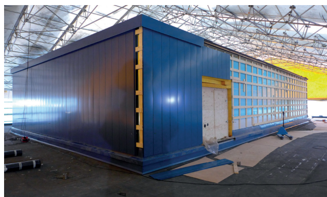
Ulkoseinien puukoolaukset sekä uusien julkisivupelttien asennus.
