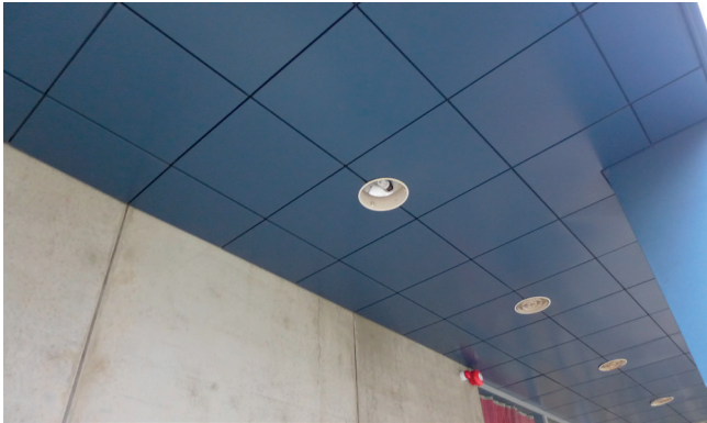
Sisäänvedon katon peltivuoraus ja alkuperäiset upotetut valaisimet.
