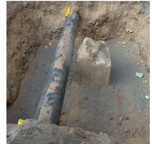
Portaiden vanhan anturan esiin kaivaminen.
