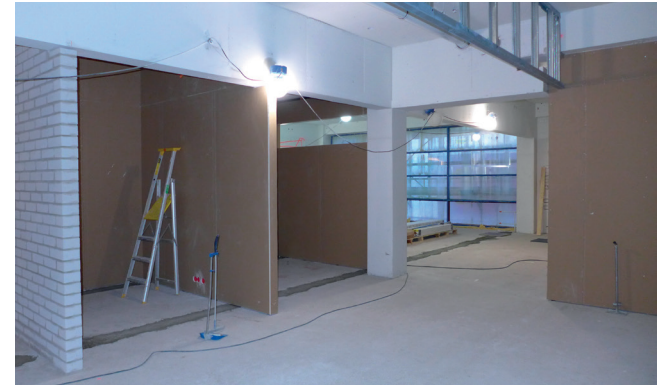
Kolmannen kerroksen uusi muurattu seinä vasemmalla sekä metallirankaisia, eristettyjä väliseiniä ennen tasoitusta ja maalausta.
