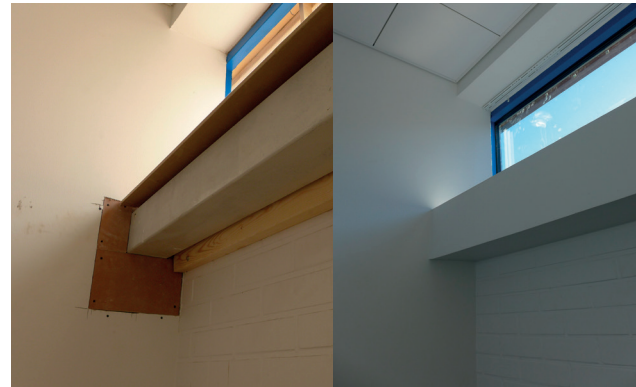
Ikkunoiden alapuolella oleva teräspalkki ja sen kotelointi. Ikkunan kohdalla ohennettu seinärakenne.
