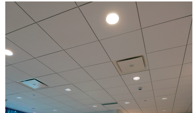
Uuden taukhuoneen katto valmiina.
