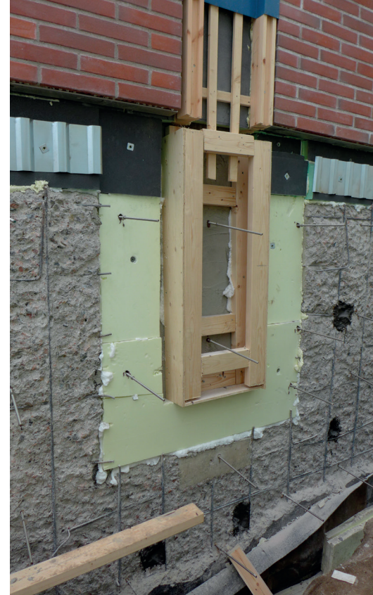
Pilaripellitysten ympärille tehtiin sokkelihalkaisun kaltainen rakenne.
