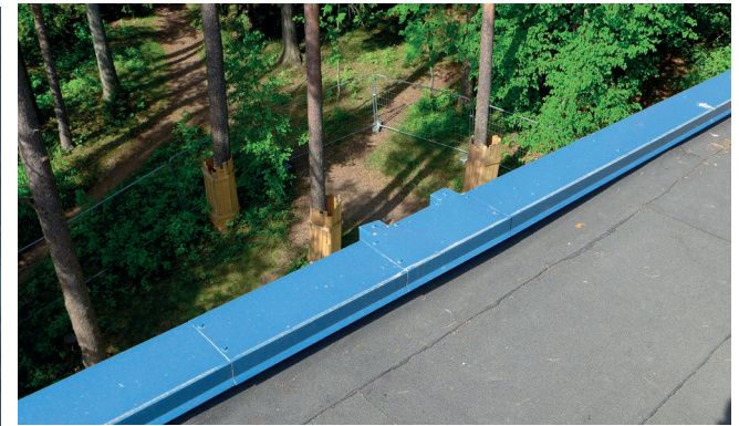
Räystään uusi pellitys.
