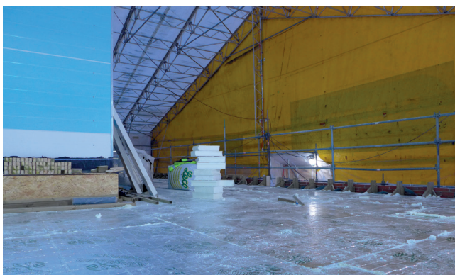
Uuden lämmöneristeen asennus.
