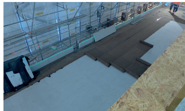
Uuden konehuoneen katolta kuvattuna alemman kumibitu- mikermin asennus tasoitettuna betonilaatan päälle.
