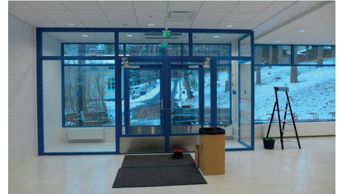
Lounaanpuoleinen sisäänkäynti korjauksen jälkeen.
