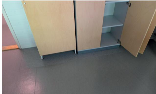
Toisessa kerroksessa oli myöhemmin lisättyä harmaata muovimattoa.
