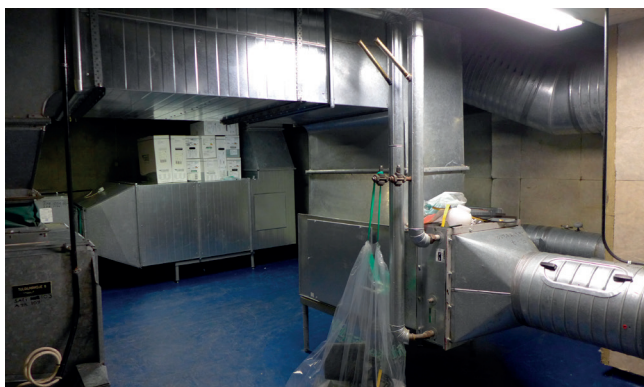
Konehuoneen sisältä ennen purkuja.
