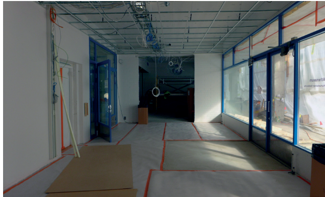
Tuulikaapin uusien ripustettujen alakattojen asennus.
