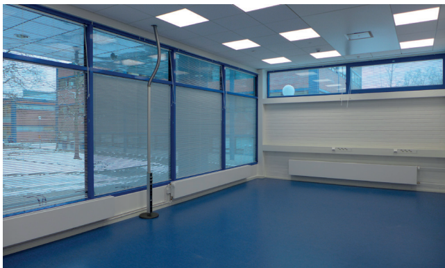
Suuren luentosalin paikalle rakennettu toimistotila. Muurattu ulkoseinä muutettiin lasiseinäksi.
