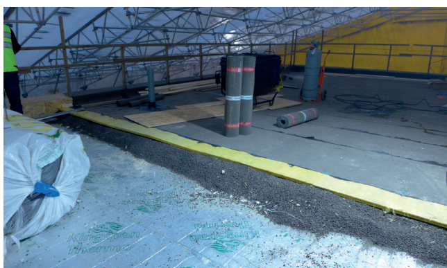
Vesikaton rakennekerroksia: polyuretaanieriste, kevytsora, mineraalivillalevy ja bitumikermi.
