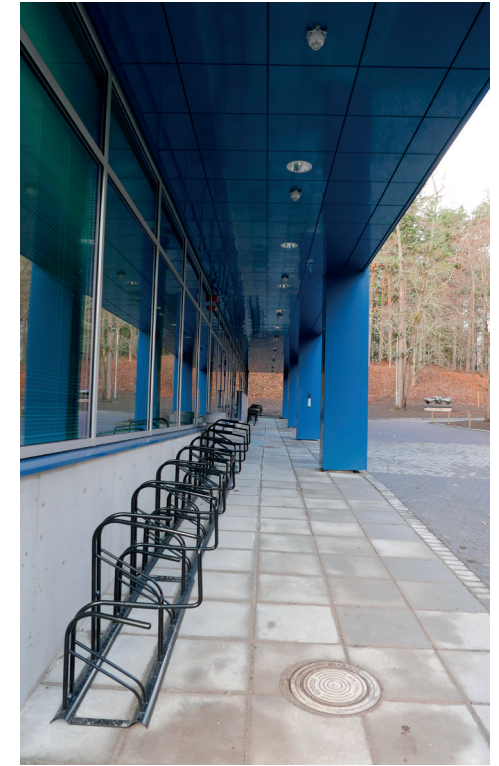
Sisäänvetoarkadi korjauksen jälkeen.
