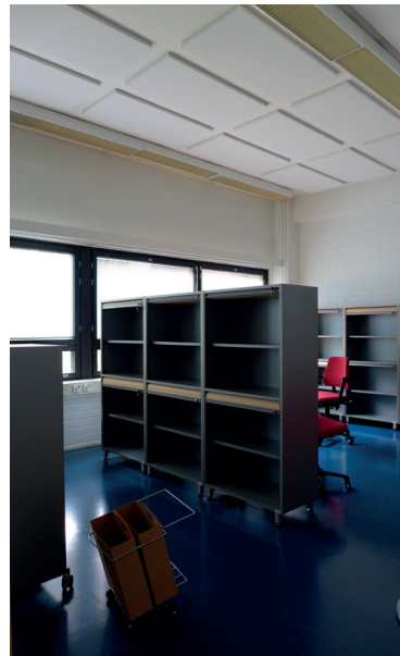
Pienempi demonstraatiohuone toimi toimistona ennen korjausta.
