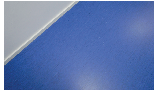
Kopiokonehuoneissa oleva yksiaineinen muovimatto ja valkoinen puulista.
