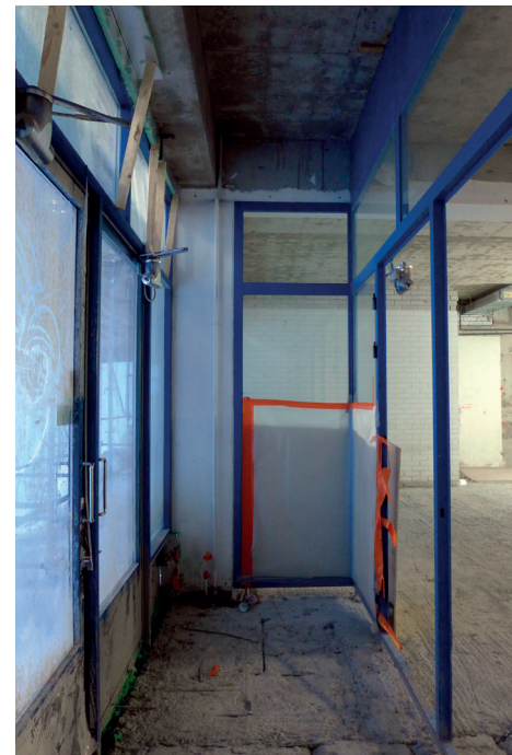
Pienen tuulikaapin metallirungot olivat paikoillaan koko korjauksen ajan.
