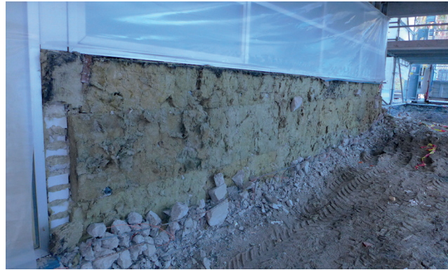
Ikkunan alapuolisen seinärakenteen purkaminen koillissivulla.
