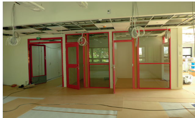
Seinien asennus ja sähköpiilien johdotustyöt.
