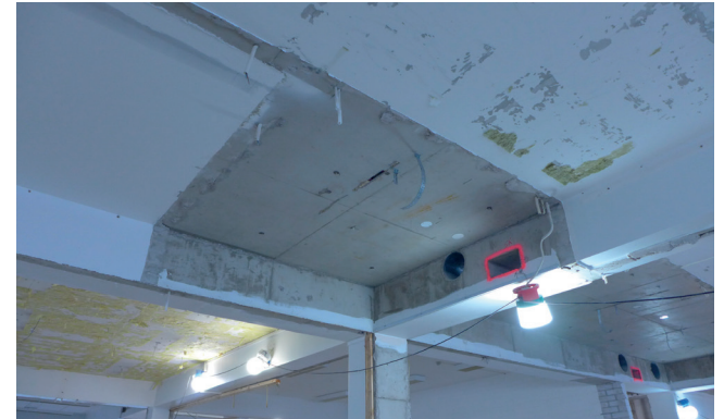
Toisesta kerroksesta on purettu käytävän laskettu katto sekä kattoon liimatut levytykset.
