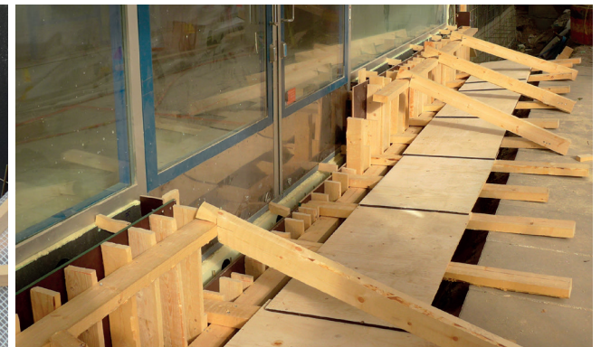
Sokkelin ulkokuoren valumuotteja.
