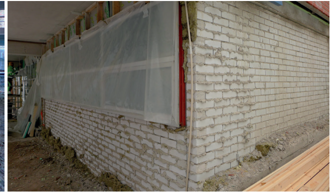
Seinärakenne on purettu muurattuun sisäkuoreen saakka. Laastipurseiden hionta seinän tasoon on aloitettu.
