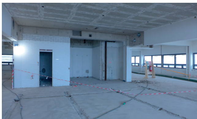
3. kerroksen lattiassa entisen kirjaston alueella olevia asennuskouruja.
