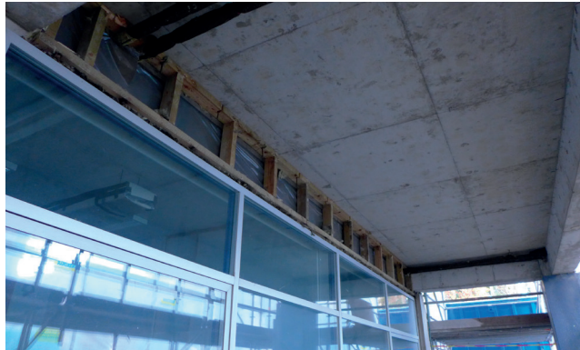
Kaikki rakenteet on purettu pois. Pinta hiekkapuhallettiin puhtaaksi.
