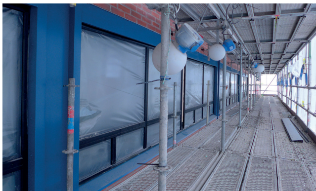
Uudet ikkunat peruskorjauksen jälkeen.
