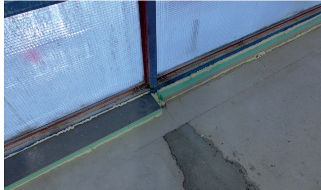
Välipohjan kohdalle laitettuja uusia eristeitä.
