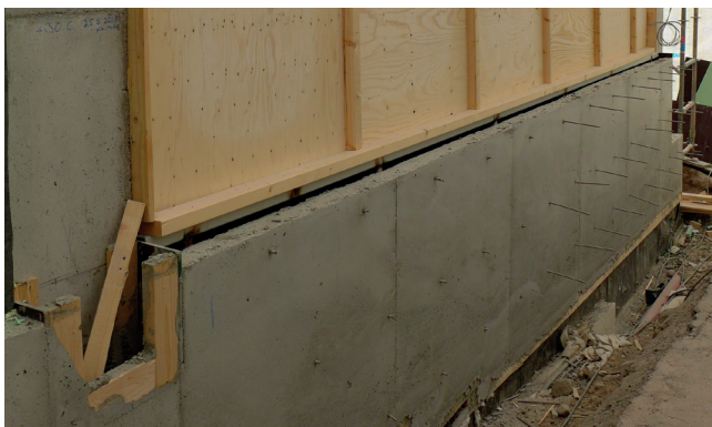
Uusi valettu betoninen ulkokuori.
