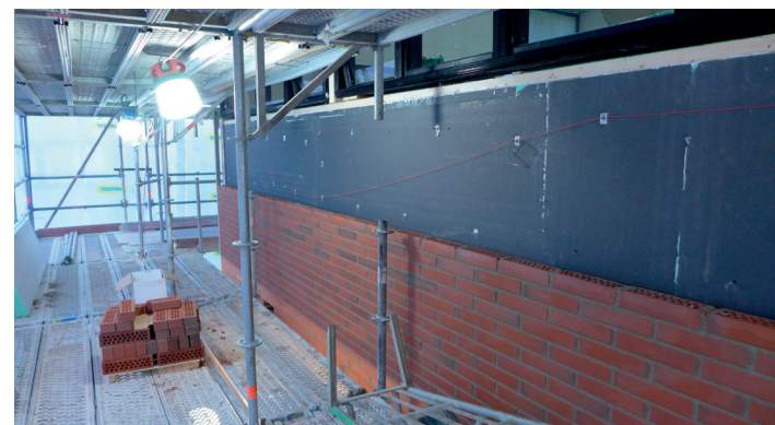
Ulkoseinän muurausta. Palosuoja- ja eristelevyn ja tiilimuurauksen väliin jätettiin tuuletusrako.
