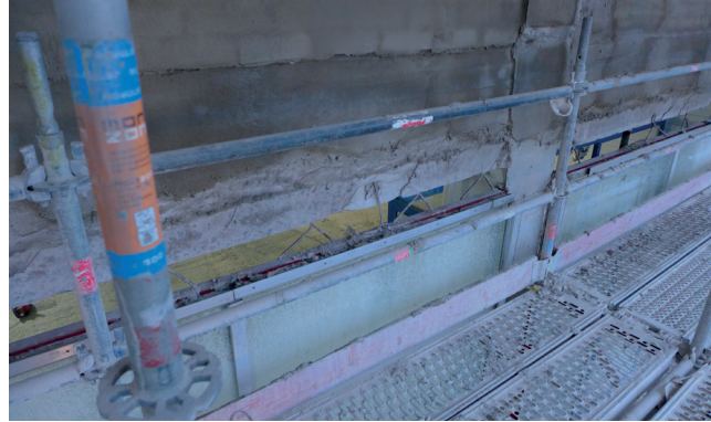
Teräsrunkojen kiinnikkeitä. Saapasalkin leuan sahausessa menetettyjä kiinnikkeitä on korvattu uusilla.
