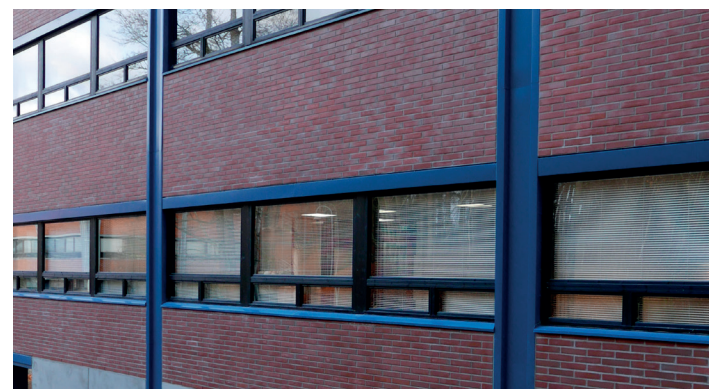
Valmista tiilistä muurattua julkisivua.
