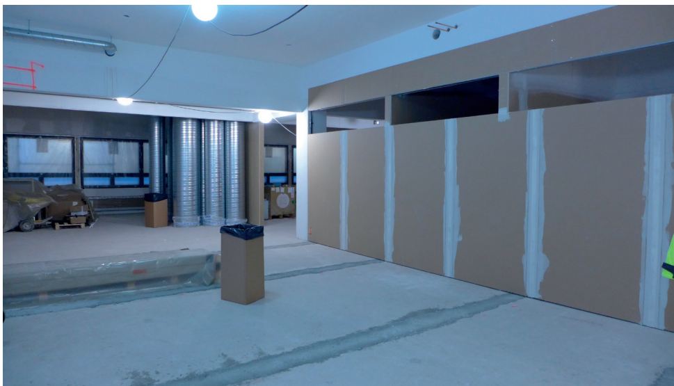
Uusien väliseinien rakennustyöt. Lattiasa näkyvät vanhat täyteen valetut asennuskourut.
