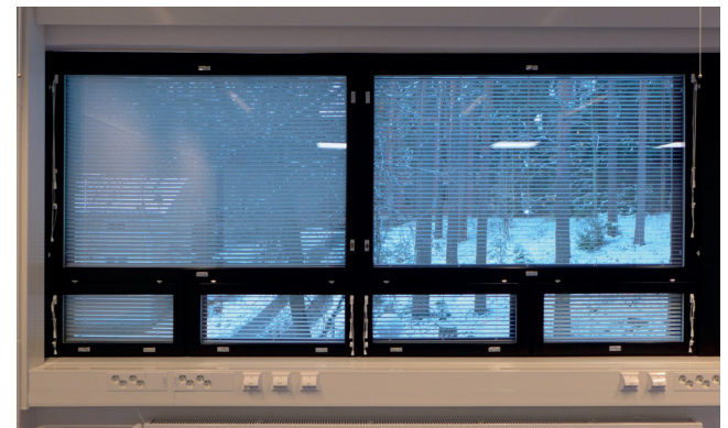
Uudet ikkunat peruskorjauksen jälkeen lounaanpuoleisella sivulla.
