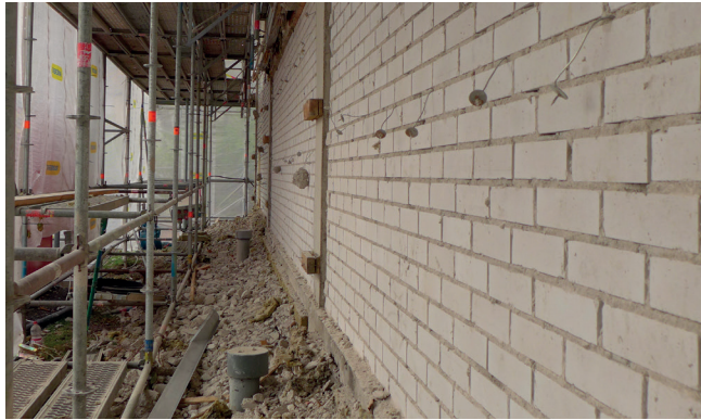
Kaakkoissivulla sisäkuoren tiilipintaa on aloitettu tasoittamaan poistamalla laastipurseita. Kiinnikkeitä on vielä poistamatta.
