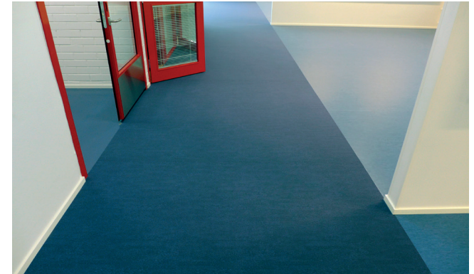
Kolme eri lattiamateriaalia: kvartsivinyylilaatta, tekstiilimatto ja desibelimuovimatto.
