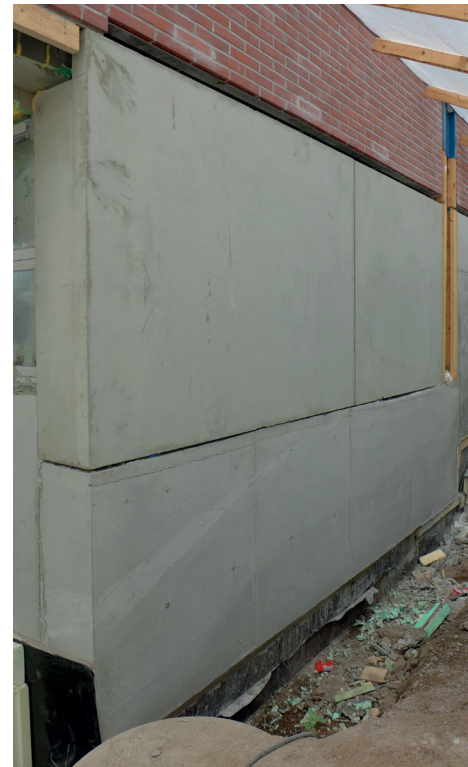
Luoteenpuoleisen sivun uudet elementit, joiden alareunaa on nostettu ylemmäs aiemmasta.
