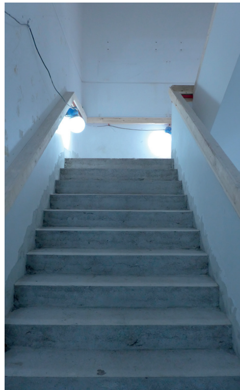
Portaiden laitoitus on purettu ja kaiteet on suojattu.
