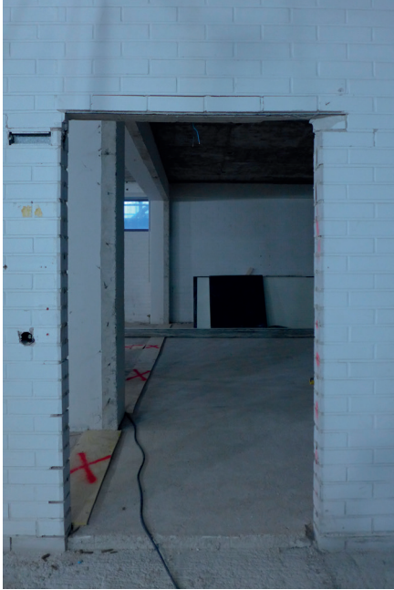
Muuratussa väliseinässä oleva oviaukko entiseen luentosaliin muurattiin umpeen.
