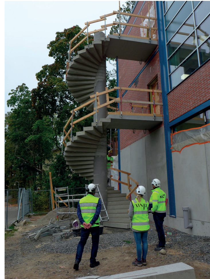
Työmaakokousta edeltävällä työmaakierroksella seurataan ulkoportaiden pinnoitustöitä.
