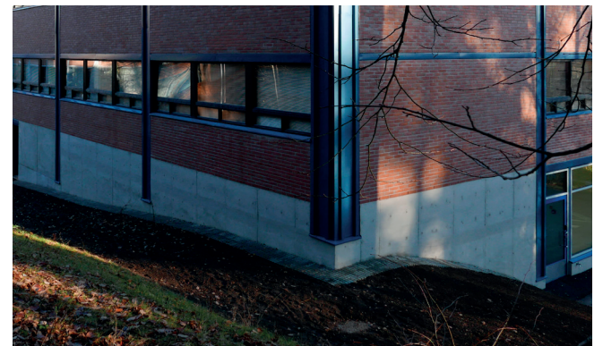
Studion maanpäälliset seinät peruskorjauksen jälkeen.
