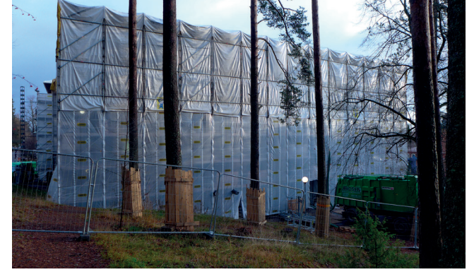
Lounaispuolella työmaa-alueen sisäpuolelle jäävien mäntyjien rungot suojattiin.
