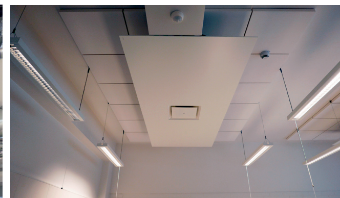
Uusi jäähdytyspaneeli, johon on integroitu ilmanvaihdon päätelaitteita.
