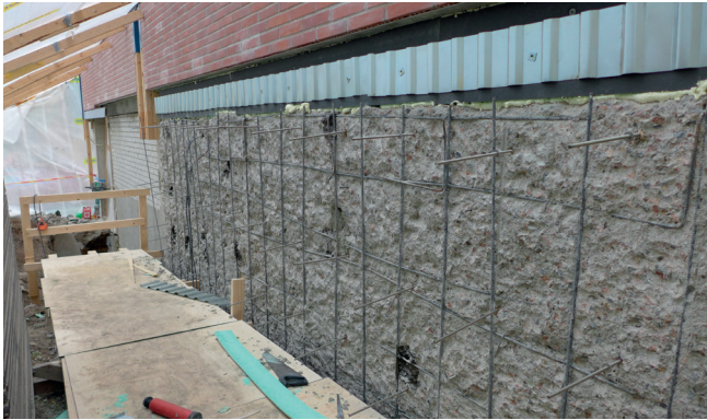
Seinien pinta piikattiin ja vanhat esiin tulleet teräkset puhdistettiin.
