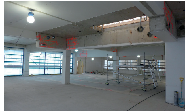
Tila purkuvaiheen lopulla. Katon aukko liittyy purettuun ilmastointikanavaan.
