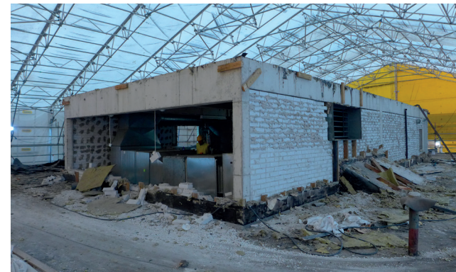
Kantava betonirakenne sekä kalkkihiekkatiilimuuraus.
