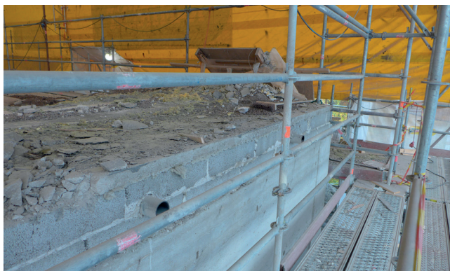
Kevytsoraharkkoreunus ja sen läpi kulkevat tuuletusputket. Pintabetonilaatan ja eristemateriaalien purku on kesken.
