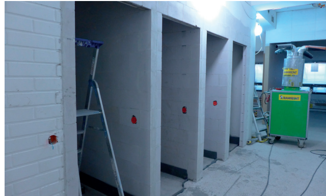
Wc-tilojen uudet kalkkihiekkaharkoista muuratut väliseinät.
