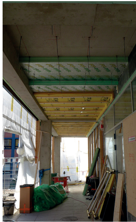
Uusien lämmöneristeiden asennus.
