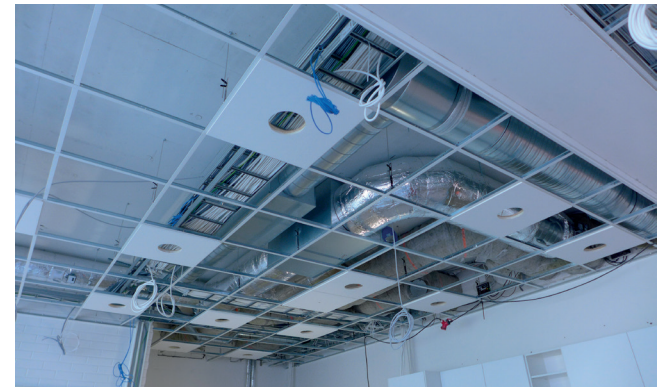
Uudet alakattolistat taukhuoneessa. Valaisinten kohdalle tulevat levyt ovat jo paikoillaan. Kuvaaja: Riikka Mäkipelkola
