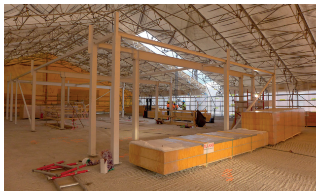
Uuden konehuoneen teräsrunгон asennus.
