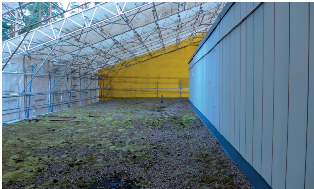
Vesikatto ennen purkutöiden aloittamista. Soran seassa jäkälä- ja sammalkasvustoa.
