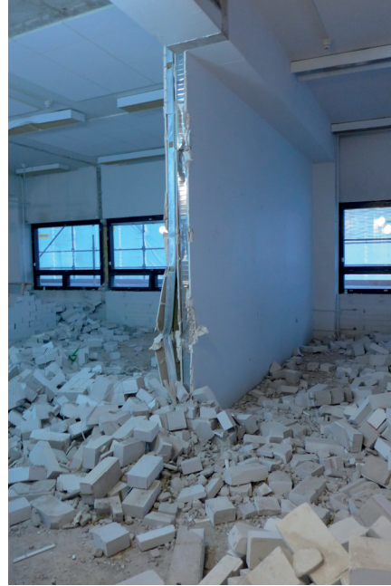
1990-luvulla lisätty metallirunkoinen väliseinä.
