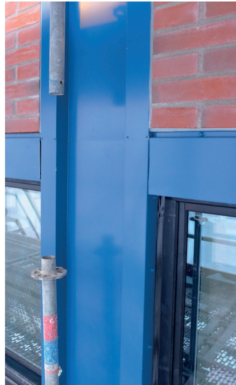
Saumattut ja valmiit pilarin ja "saapasalkkien otsien" peltiverhoukset.
