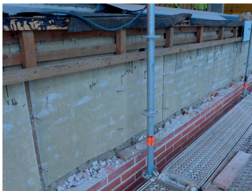
Seinän yläosassa oli lisäksi kuitusementtilevyä ulkomuurauksen ja eristeen välissä. Ylhäällä puiset räystärakenteet.
