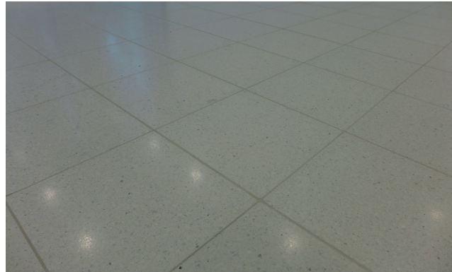
Aulatilän uusi mosaiikkibetonilaatoitus.
