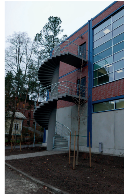
Uusi kierporras. Portaisiin lisättiin alas turvaportti.
