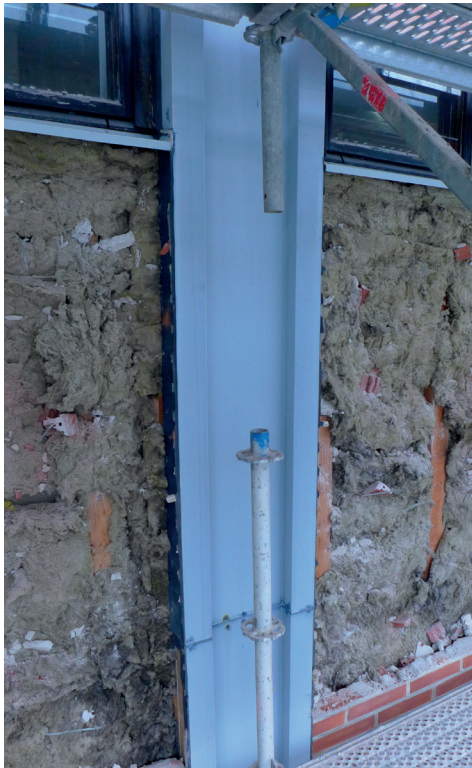
Pilarin vanha peltiverhous ja peltien sauman alkuperäinen toteutustapa.
