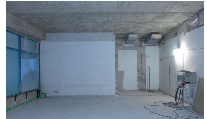
Aula purkutöiden loppuvaiheessa. Keittokomero on purettu kokonaan.
