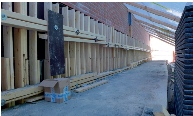
Seinän valumuotit. Kuvaaja: Riikka Mäkipelkola
