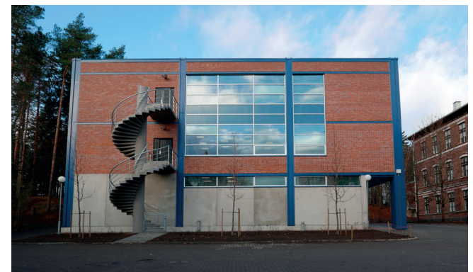
Kaakkoissivun lasiseinä korjauksen jälkeen. Alkuperäiset värit on palautettu haalistuneille alueille.
