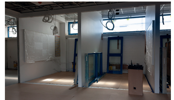
Ensimmäisen kerroksen puisten lasiseinien asennus valmiina alkamaan. Kuvaaja: Riikka Mäkipelkola
