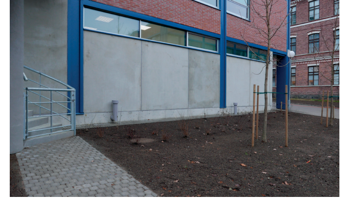
Kaakkoissivun valmiit betonielementtipinnat. Sokkeli on aiempaa korkeampi.
