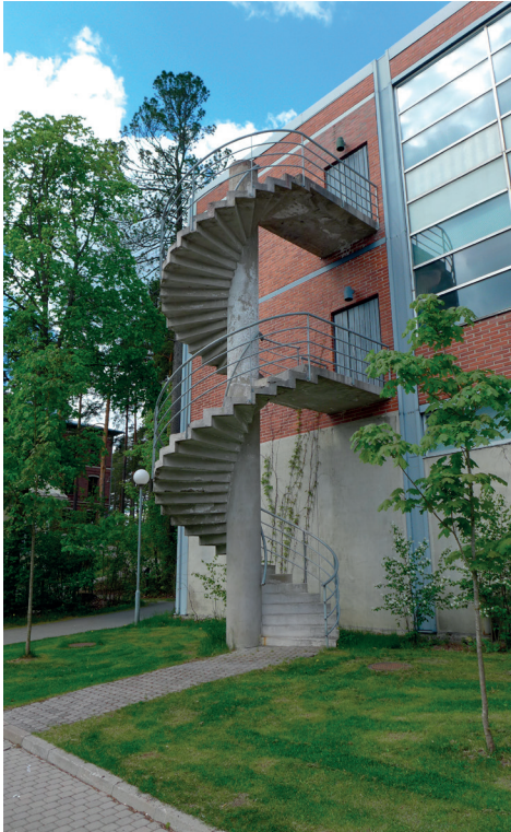
Kierreportaat ennen peruskorjauksen alkua.
