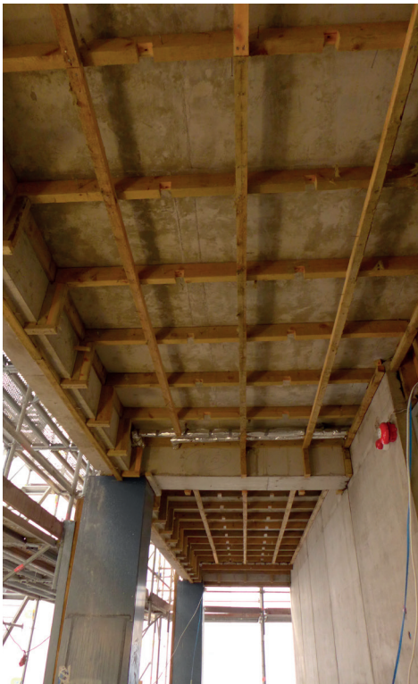
Lämmöneristeet on purettu, jäljellä alaslaskun vanhat puurakenteet.
