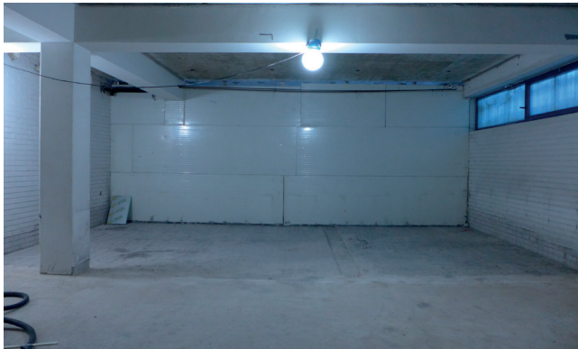
Porrastus on purettu ja samoin ulkoseinä, joka on talven ajaksi korvattu väliaikaisella Paroc-seinällä.
