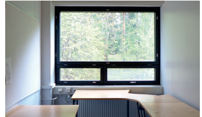
Vanha ikkuna. Pilarin vieressä olevat ikkunat olivat hieman keskimmäisiä kapeampia, minkä huomaa pienistä ruuduista.
