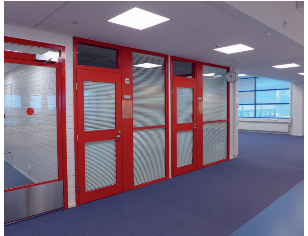
Pienen työhuoneen ja vetäytymistilan puurakenteinen lasiseinä ovineen. Ovien yläpuolisissa lasissa ei ole sälekaihdinta.
