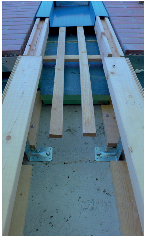
Uuden pilaripellityksen rakenne. Kuvaaja: Riikka Mäkipelkola
