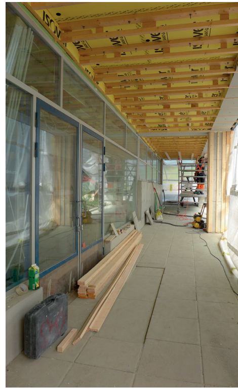
Uusien puurakenteiden rakentaminen.
