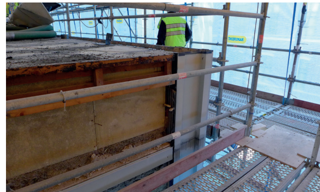
Bitumikermitte on poistettu ja julkisivumuurausta purettu. Räystään puiset rakenteet ovat näkyvillä.
