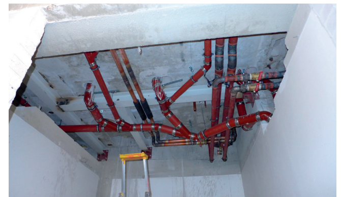
Uuden iv-kuilun kohdalla välipohjan laattaa vahvistettiin teräspalkeilla.
