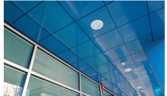
Uudet peltikasetit, valaisimet ja lämpöilmäisimet.
