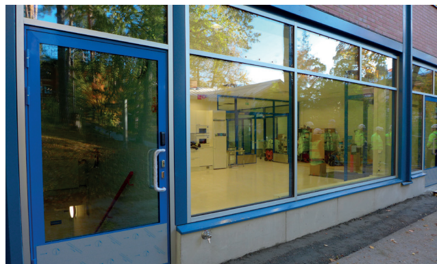
Ikkunoiden alapuolinen sokkeli lounaanpuoleisella sivulla.
