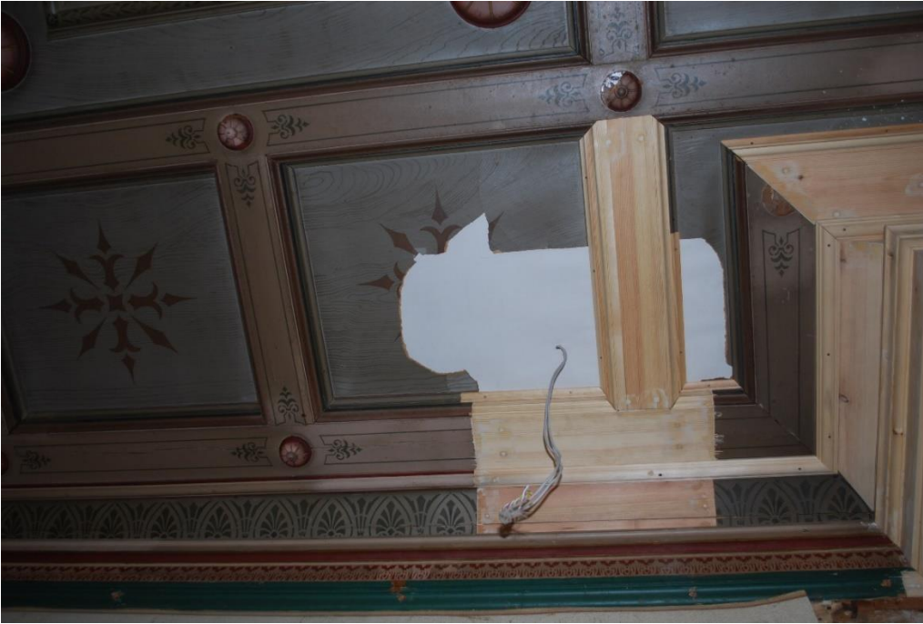
Kuva 35. Salongin kattoa on korjattu. Kuva: Mari Vasara 2010.
