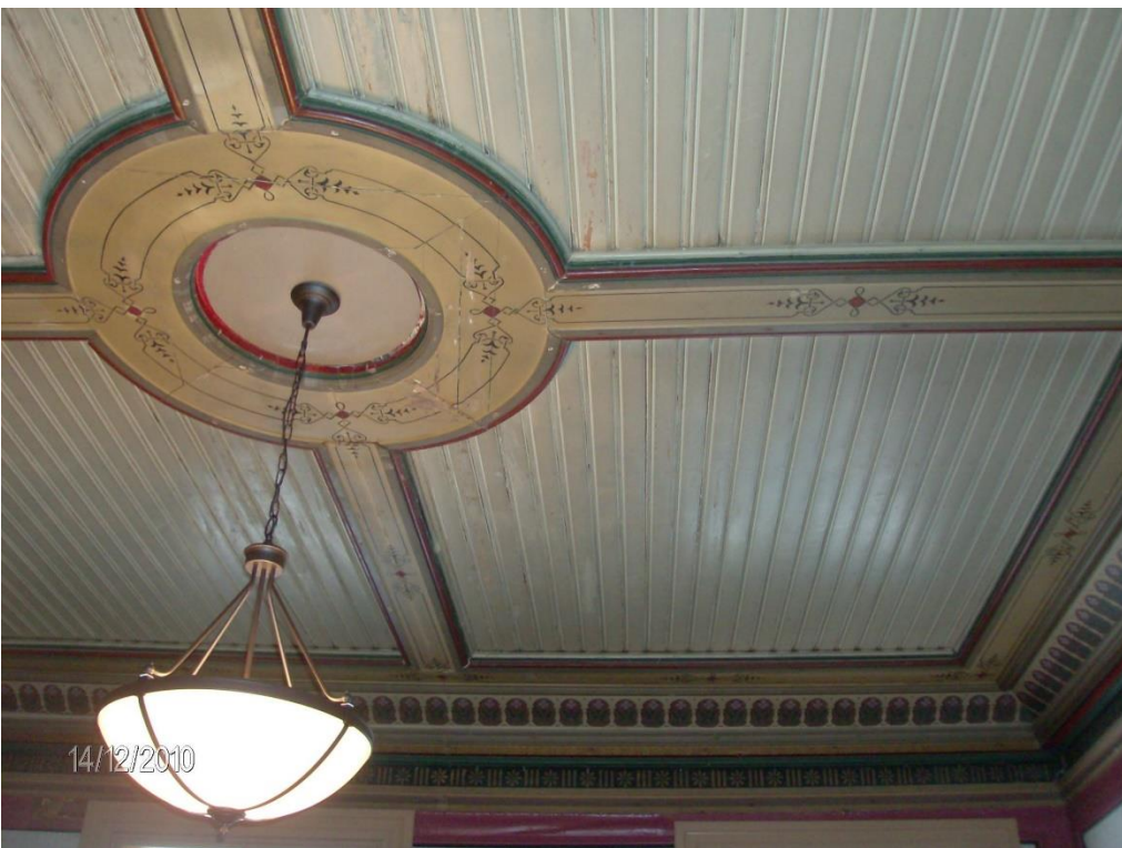
Kuva 34. Keisarillisen odotussalin katto korjattuna avajaisissa 14.12.2010. Kuva: Juhani Sirkkiä
