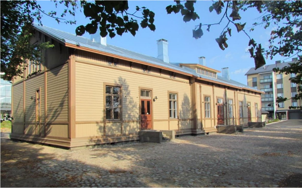
Kuva 38. Keisarin asema kesällä 2011 pihan puolelta kuvattuna. Kuva: Juhani Sirkiä.
