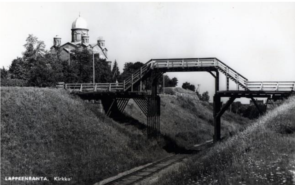
Kuva 28. Sotakorvauskuormia varten korotettu Huokausten silta vanhan aseman ja Rapasaaren aseman välisellä rataosuudella 1950-luvulla. Sillan takana Lappeenrannan kirkko. Kuva: Lappeenrannan museot.
