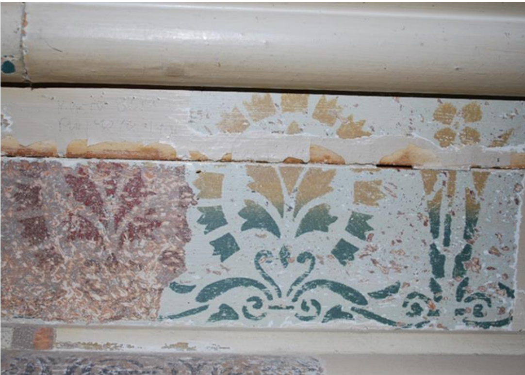
Kuvat 5–7. Esiinottoja I–II -luokan odotussalin katossa. Kattolistaan on maalattu palmettiaihe kuten salongissakin, mutta hiukan eri tyyllisenä. Vanhimmat kuviot on maalattu uudelleen samantyyloisina ennen yksiväristä maalauspinnaa. Kuvat: Mari Vasara 2010.
