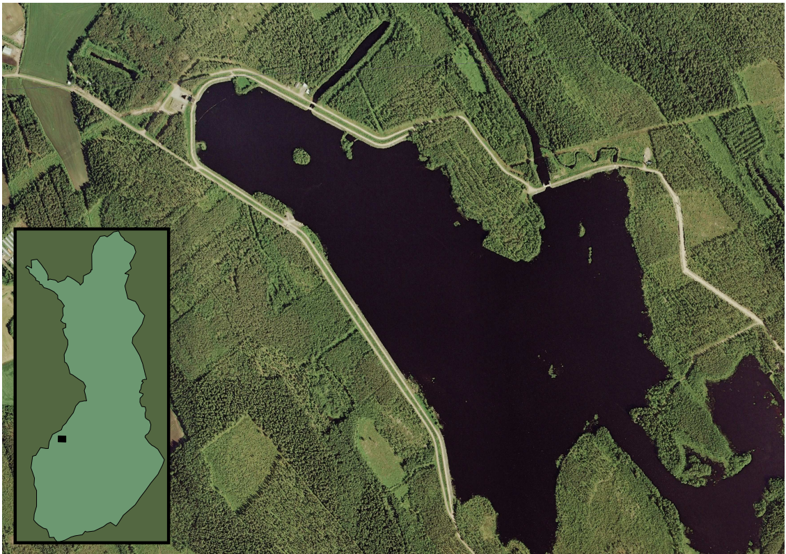
Kuva 1.1: Kaitforsin patoallas. (Koostettu Maanmittauslaitoksen Maastotietokannan 3/2017 aineistosta: Creative Commons 4.0 [9].)
