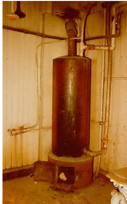
Vasemmassa kuvassa on entisen pukuhuoneen kulmikas uuni, joka purettiin peruskorjauksessa ja sen tilalle rakennettiin siivouskomero. JYM. Oikealla on ryöppyhuoneen vanha kamiini, jolla lämmitettiin pöntössä ollut vesi. Se purettiin niin ikään vuoden 1981 korjauksessa. JYM
