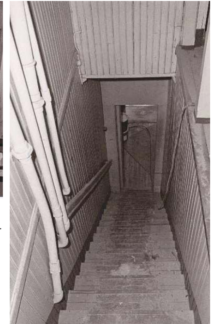
1960-luvun korjaustöissä talotekniikka uusittiin Ryhtilässä. Vanha vesisäiliö jätettiin yläkerran seinään putkistoineen. Säiliö purettiin vasta vuoden 1981 peruskorjauksessa. SYK.
