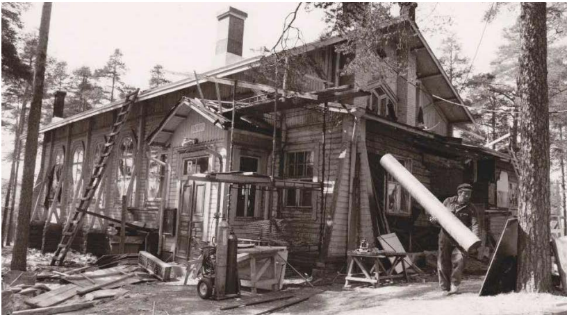
Ryhtilän peruskorjaus käynnissä vuonna 1981. K1574:43 JYM.
