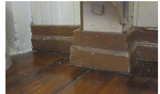
Salin lattialistoitusta. Pilasterin etuseinämässä on uudelleen tehty lista. Vanhoissa listoissa on nähtävissä useita maalikerroksia pintamaalin alla. 2013.
