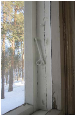
Alkuperäinen ikkunan myrskyhaka.
