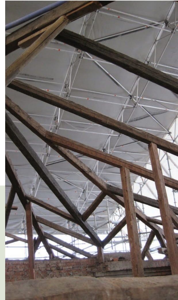
66. Rakennuksen kattorakenteet purkuvaiheen päättyessä.
