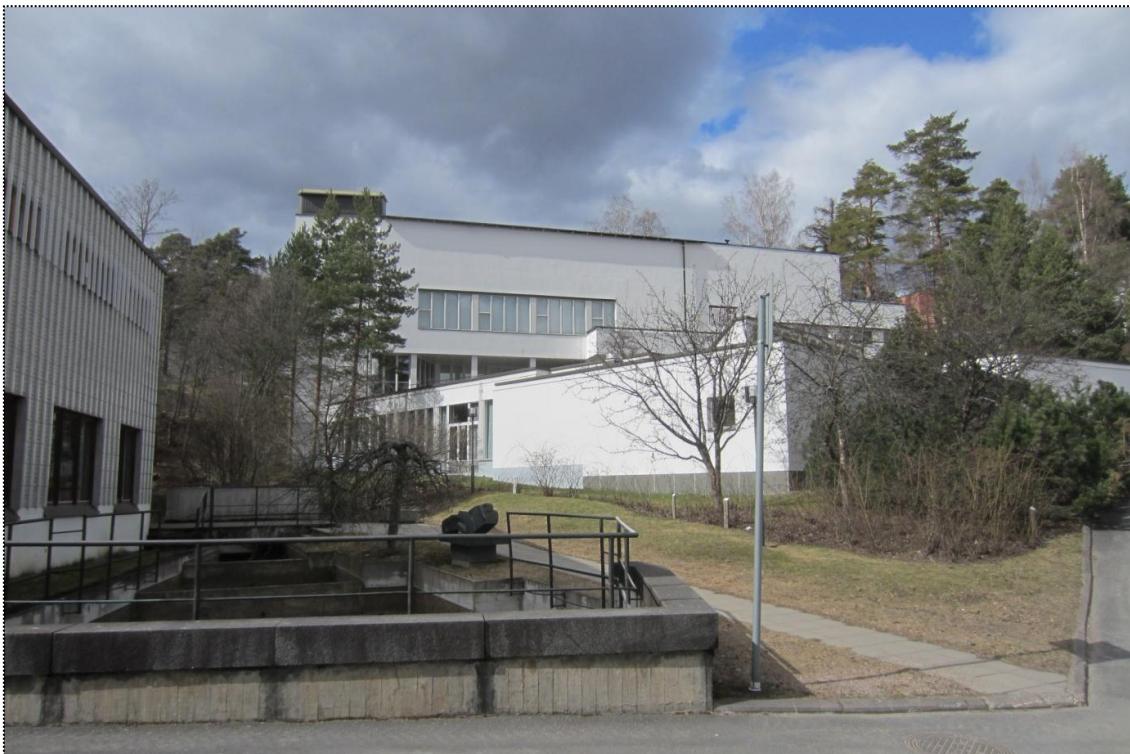
Kuva 55. Keski-Suomen museon alle lisärakennuksen alle (matala osa) jäi osa Ruusupuistoa. Vasemmalla Alvar Aalto -museo ja sen vieressä oleva vesiallas. A-MM-L.
