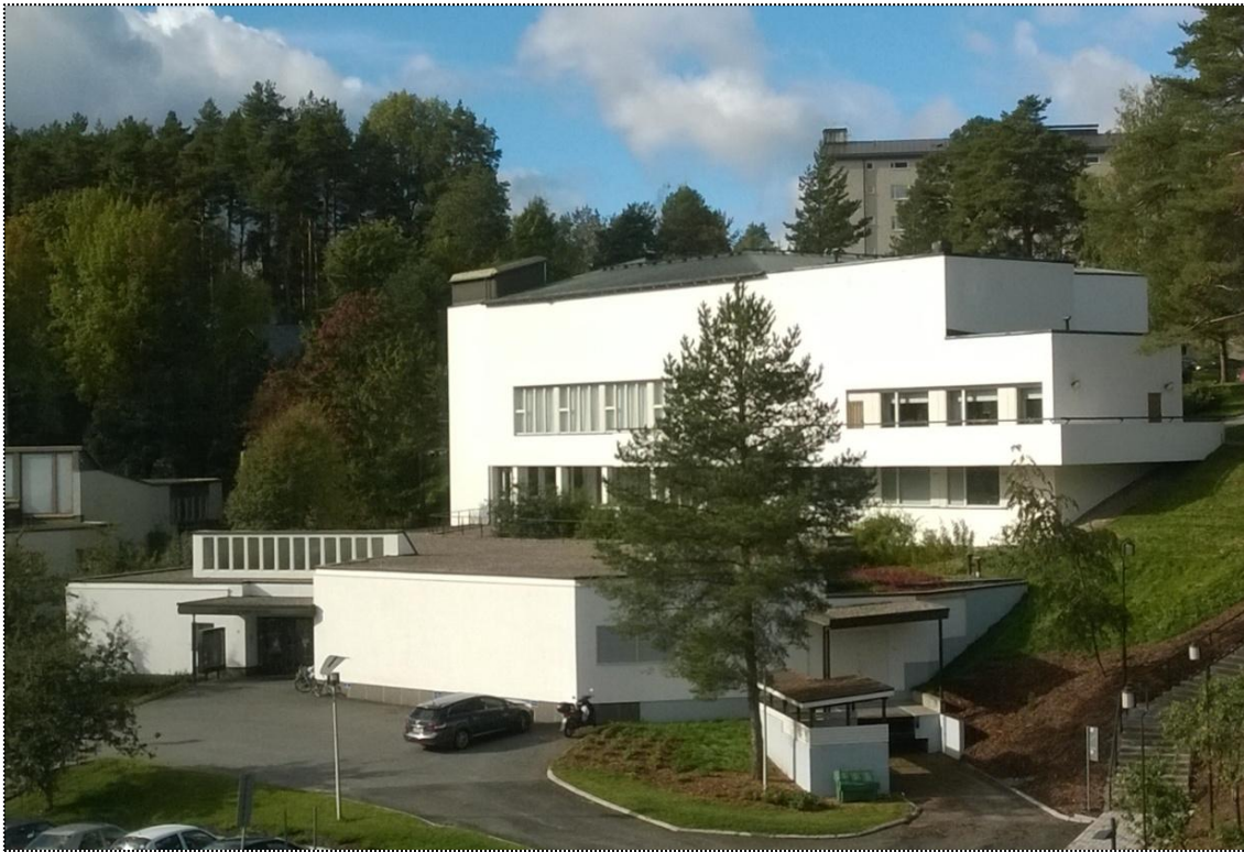
Kuva 48. Keski-Suomen museo syyskuussa 2015. Alimpana laajennusosa pääsisäänkäynteineen ja ylempänä museon vanha osa. Vanhan osan alakerrassa pylväikkö ja henkilökunnan työhuoneita. Keskihakerroksessa on näyttelysalin tasainen ikkunarivistö sekä kahvila terasseineen. Ylin kerros on ilman siviikkunoita. Vasemmalla pilkottaa Alvar Aalto -museota. A-MM-L.
