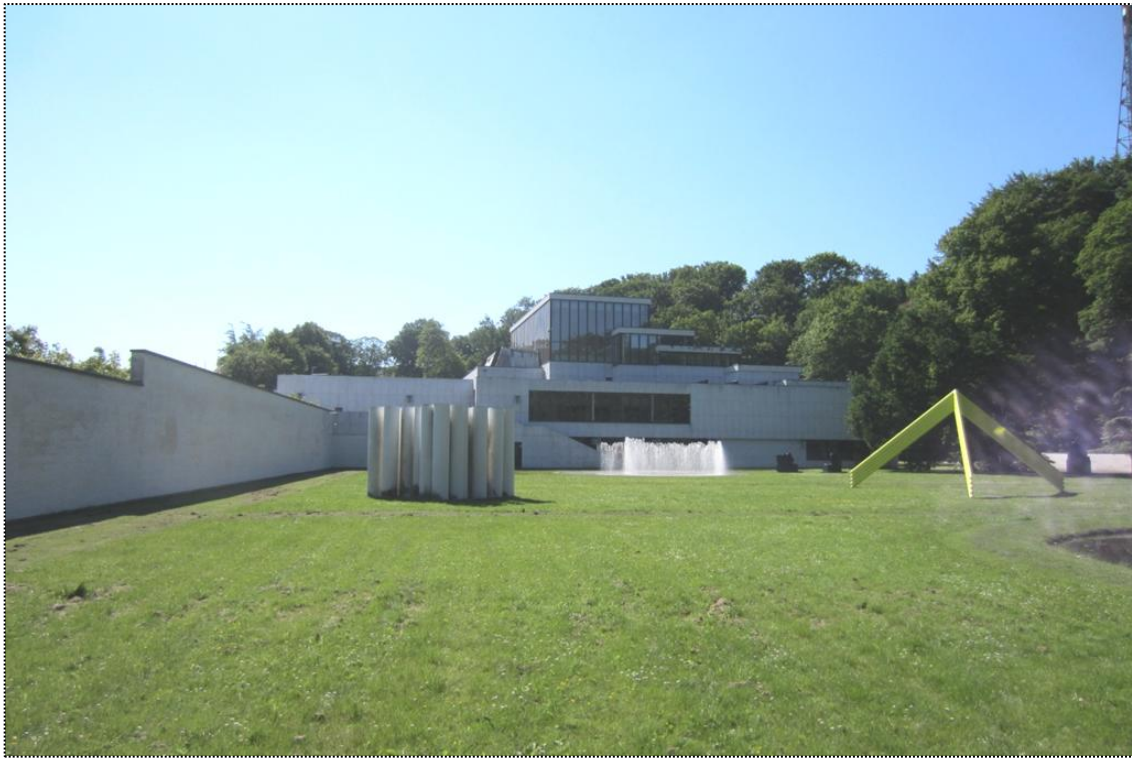
Kuva 64. Museo muurien ympäröimän veistospuiston suunnalta kesäkuussa 2012. Ikkunarakennelmat kohoavat rakennusmassan ylle porrasympyrämuotoon. A-MM-L.
