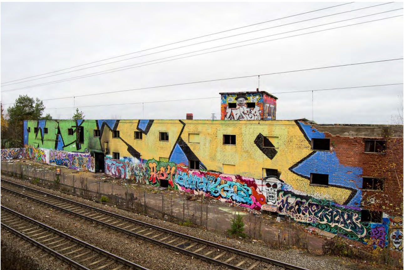
Kuva 2. Kattohuopatehtaan eteläfasadi (Kai Ylinen 2013). Radan toisella puolella kulkee feimin muuri.
