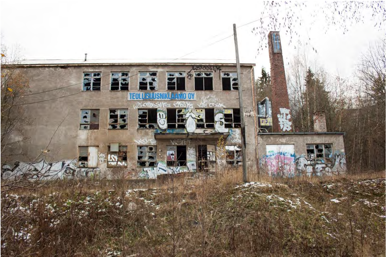
Kuva 4. Luujauhotehtaan pohjoisfasadi ja piippu (Kai Ylinen 2012).
