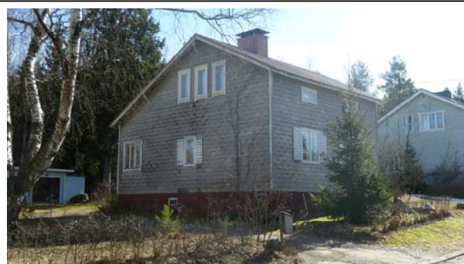
Omakotitalo keväällä 2014. Talon julkisivumateriaali on vaihtunut aikanaan puusta Mineriiitti-levyihin. Katto ja ikkunat on uusittu. Avokuisti on muutettu lämpimäksi tilaksi. Arvoluokka on 1.
