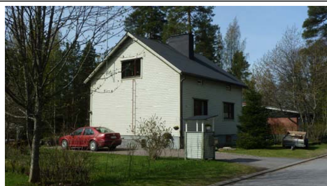
Omakotitalo keväällä 2014. Talon ulkoinen ilme vastaa rakentamisaikakauttaan. Taloon on tehty tyyppilliset muutokset: ikkunat, katto ja julkisivut uusittu. Arvoluokka on 1.
