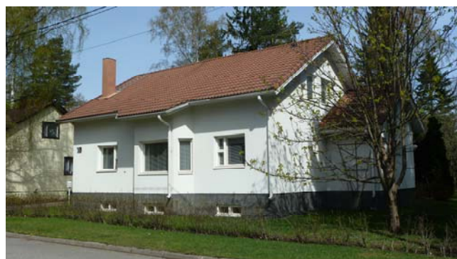
Tontti 916-9. Nykyisen asuinrakennuksen on suunnitellut Jouko Leskinen vuonna 1992. Alkuperäinen J. H. Yli-Koveron suunnittelema talo vuodelta 1949 on purettu. Nykyinen rakennus sopii mittakaavaltaan hyvin ympäröivään rakennuskantaan
