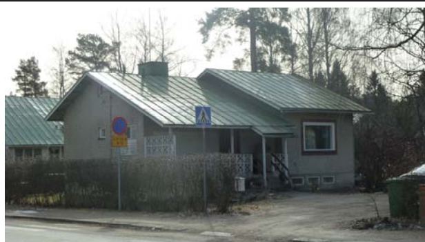
Tontti: 921-9. Rakennuksen on suunnitellut T. Keto vuonna 1955. Ajalle epätyypillinen pohjaratkaisu: talon asuin kerros koostuu keittiöstä ja 4 huoneesta. Tilat sijoittuvat käytävän varrelle, jonka päässä wc. Olohuone on kooltaan kaksinkertainen muihin huoneisiin nähden.
