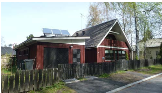
Tontti 924-8. Asuintalon ja autotallin on suunnitellut Kari Keinänen vuonna 1975. Talo edustaa aikansa ns. käkikellotaloa. Asuinrakennuksen ja autotallin sijoitus vierekkäin lähelle katua ei kuulu alueen ominaispiirteisiin.
