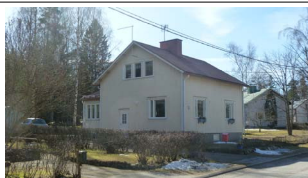
Omakotitalo keväällä 2014. Talon kuistia on vähän muutettu peruskorjauksen yhteydessä. Lisäksi talon katto, ovet, ikkunat ja julkisivuverho on uusittu. Arvoluokka on 1.
