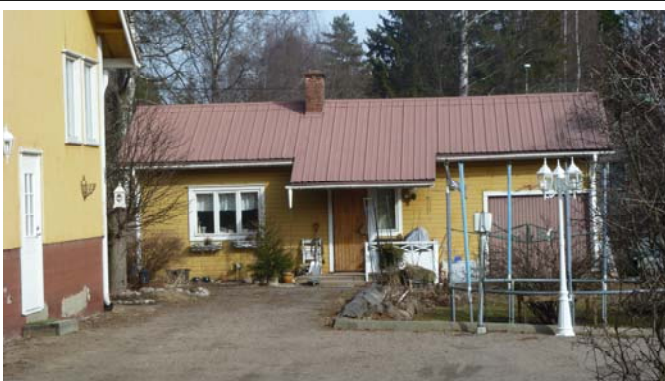
Tontille 921-18 olevan taloussrakennus on suunnitellut Kalle Eloranta vuonna 1951. Ikkunoita lukuun ottamatta rakennuksessa näkyy alkuperäisyys. Kuva on keväältä 2014.
