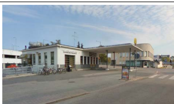
Kuvassa on rakennussuojelulain suojeltu entinen Shellin huoltamorakennus.
