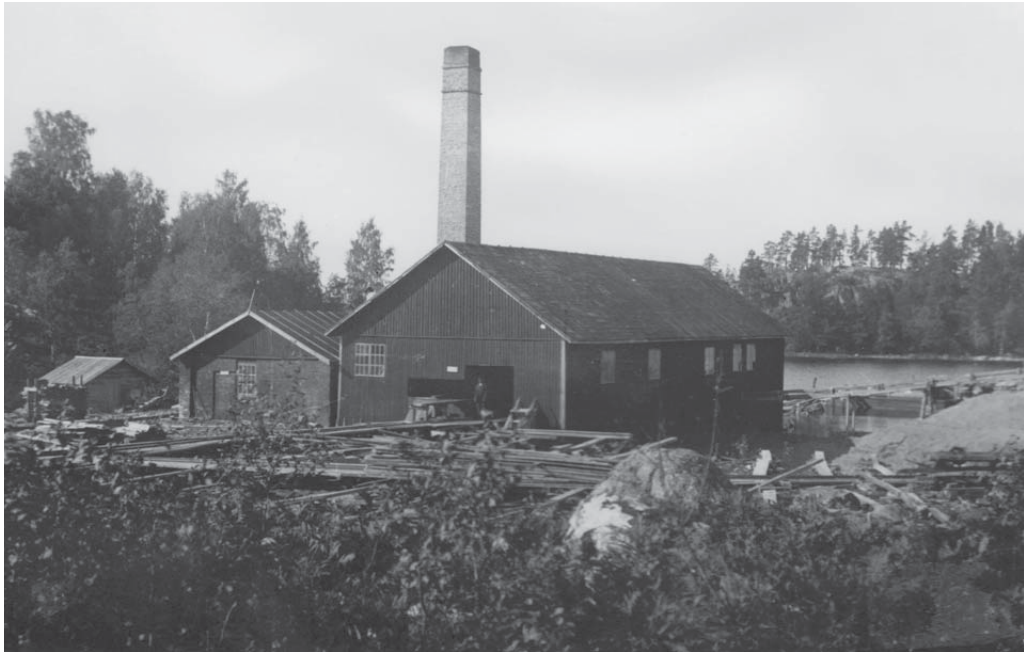
Kettulan vanha saha 1920-luvulla. Mikko Kaloinen oli laatinut itse koneiden asennus- ja rakennuspiirroksset.
