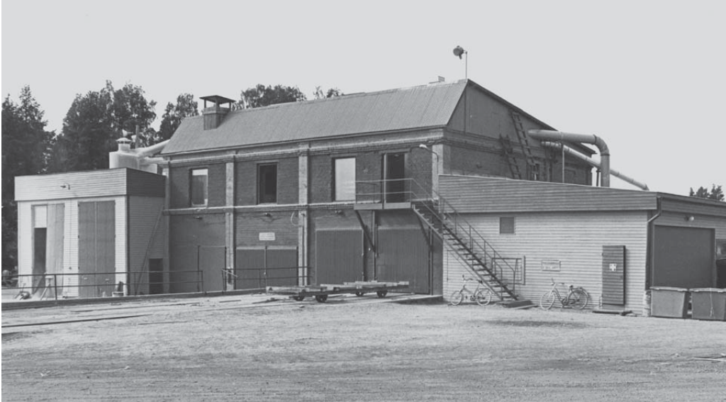
Kettulan sahan höyläämö ja kamarikuivaamot. Aikaisemmin rakennuksessa oli toiminut lämpövoimala. 1960-luvulla puutavaraa kuivattiin monin eri tavoin: kamarikuivaamoissa, tapuleissa sekä sahojen laivauksen yhteiskuivaamolla Paraisilla.
