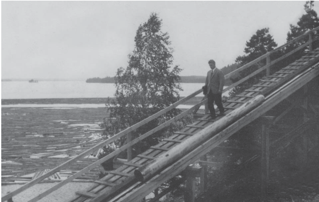
Aimo Kaloinen kävelemässä Kettulan sahan tukkien syöttösillalla. Kuva on otettu 1960-luvun alkupuolella Aimo Kaloisen ollessa jo Oy Mikko Kaloisen toimitusjohtaja.
