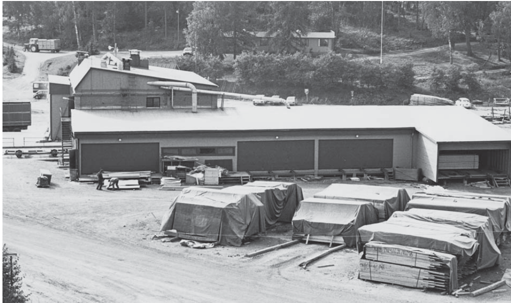
Kuvassa Kettulaan rakennettu höyläämö ja kamarikuivaamot. Höyläämön siirtäminen Hämeenlinnasta Kettulaan keskitti tuotantoa yhä selvemmin sahan välittömään läheisyyteen.
