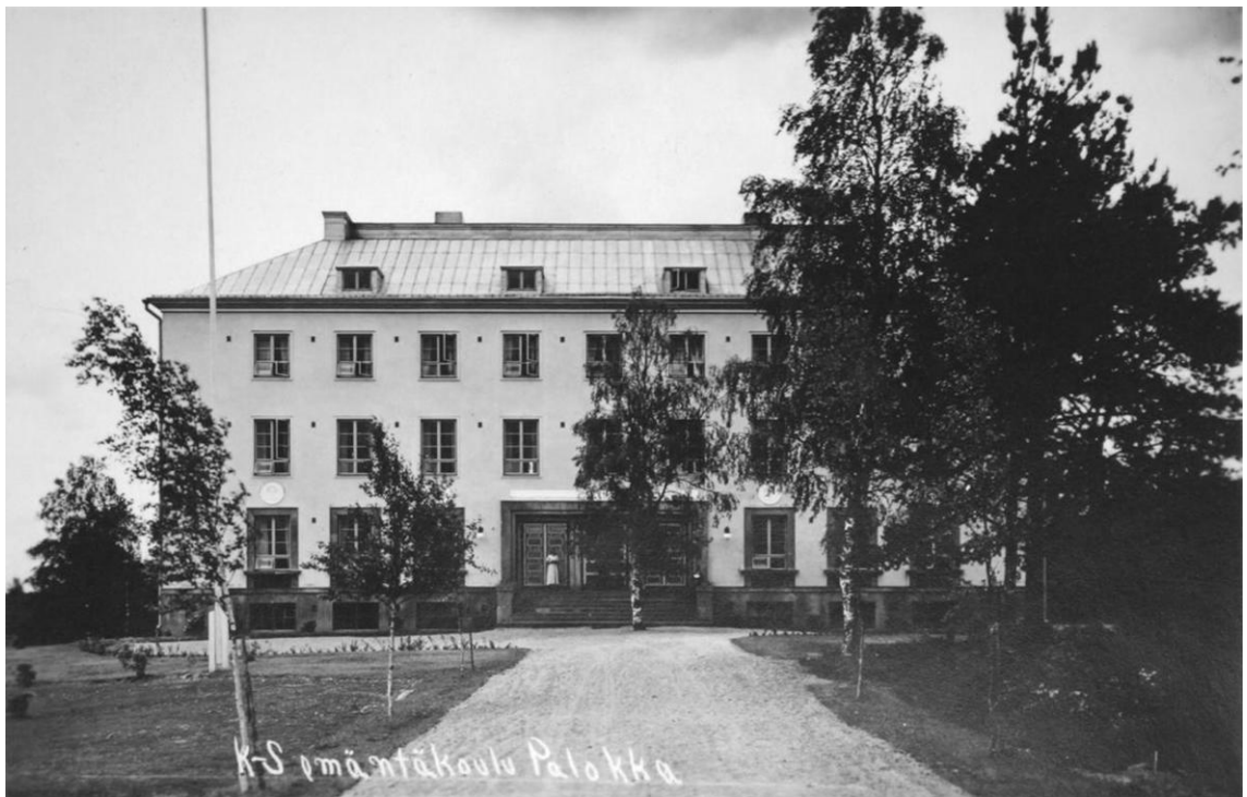
KUVA 6. Koivukujanne oli emäntäkoulun pääväylä. Etupihaa reunustavat pensaat ovat vastaistutettuja.
