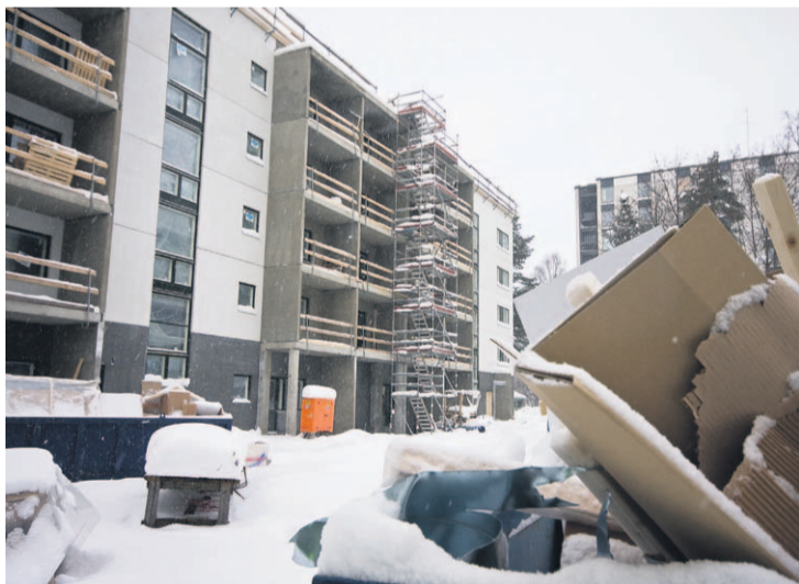
J-talo valmistuu toukokuuksi. Seuraavana on valmistumisvuorossa naapuritalo H, jonka kattosaunaan pääsee J:stäkin saunaan.
