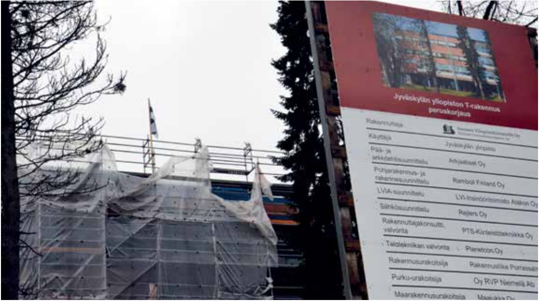
T-rakennus korjattiin Terve talo -periaatteella.
