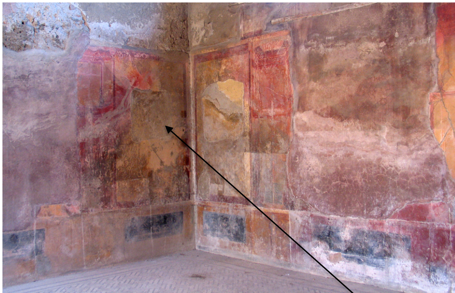
Kuva 2. Marcus Lucretiuksen talon (IX 3, 5.24) tricliniumin kaakkoiskulman seinämaalauksipintojen kunto vuonna 2004. Kuva: EPUH
