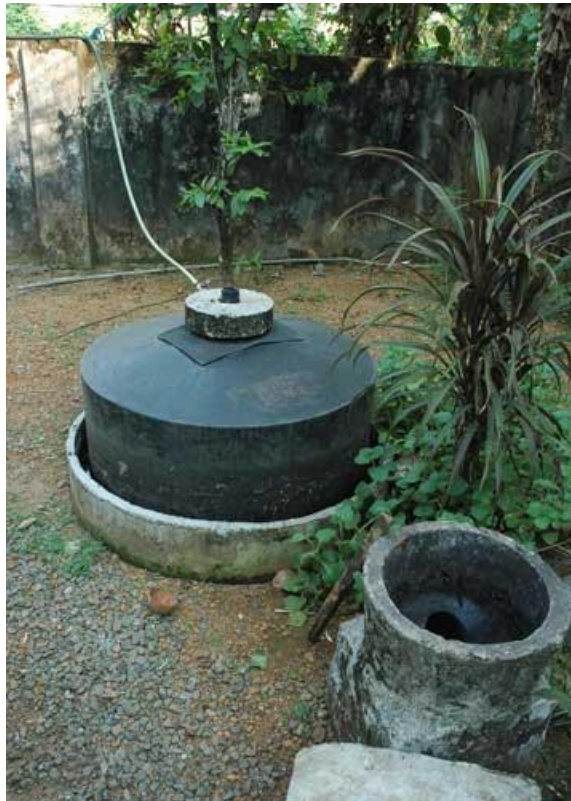
Kuva 1. Kiinteistökohtainen biokaasureaktori Keralassa Intiassa. Reaktorin päältä lähtevä letku johtaa suoraan keittiön kaasukeittimelle (The Open University 2012).
