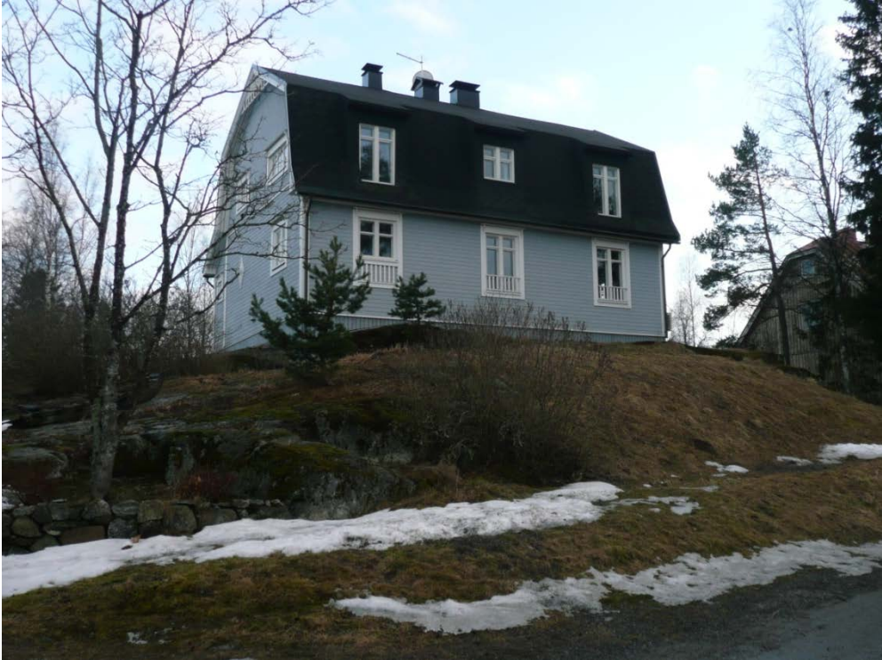
Kuva 11. Uudisrakennus alueen pohjoisrinteellä.
