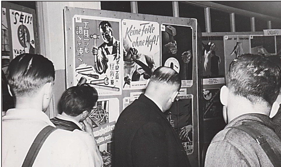
KUVA 10 Yhtiö uskoi työturvallisuudessa julisteiden voimaan. Työturvallisuusnäyttely Paperituotteella vuonna 1951. Katso myös liite 5 ja liite 6. Lähde: UPM, VA, TU3, C1388.
