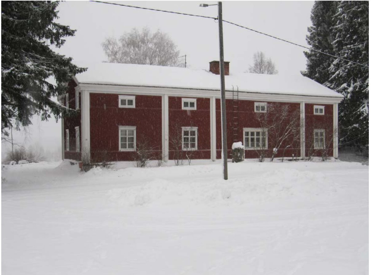
Kuva 3.1 Viljatila 1:n päärakennus.
