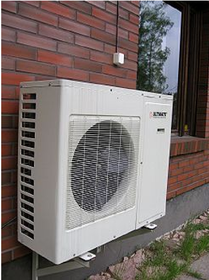
Kuva 2.15 Ilmalämpöpumpun ulkoyksikkö.
