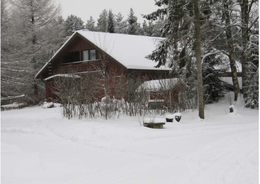
Kuva 3.3 Viljatilan 2:n päärakennus.
