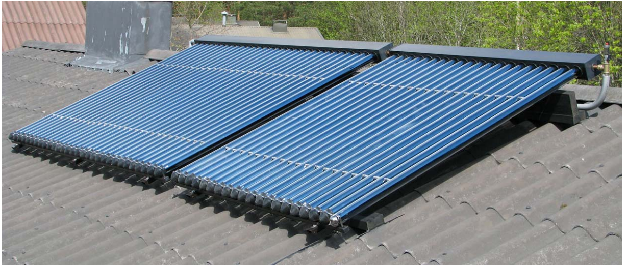
Kuva 2.27 Consol -tyhjiöputkikeräin käyttöveden lämmittämiseen.
