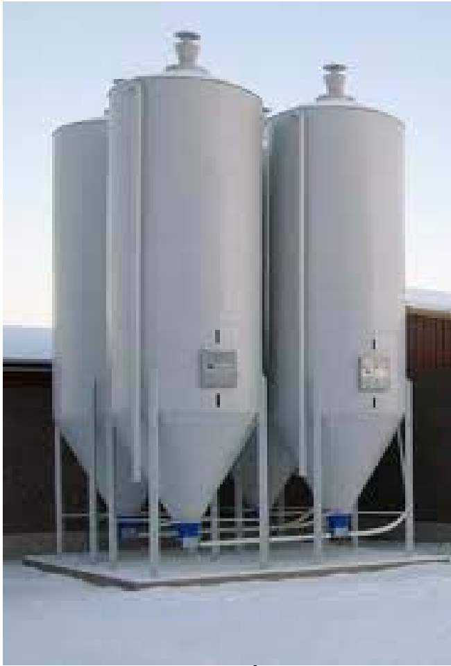
Kuva 4.4 Neljä Triotec 24 m 3 :n pellettisiiloa.
