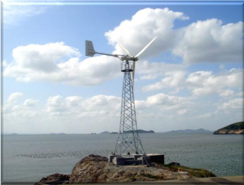
Kuva 5.3 WPE 20 kW:n tuulivoimala.
