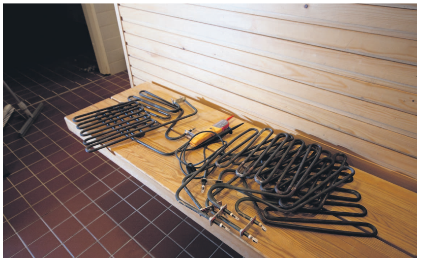
Kaikki vanhat vastukset olivat vielä vaihdettaessa ehjiä. Toimimattomissa vastuksissa ei siis ole ollut Opinkiven lauhojen löylyjen syy.
