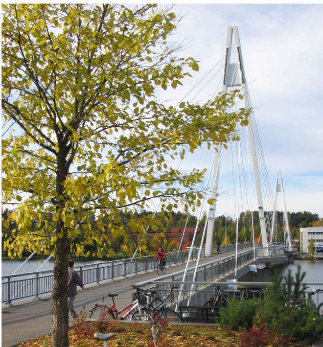
Kuva 1: Jyväsjärven ylittävä kävelysilta yhdistää Ylistönrinteen ja Mattilanniemen kampukset.
