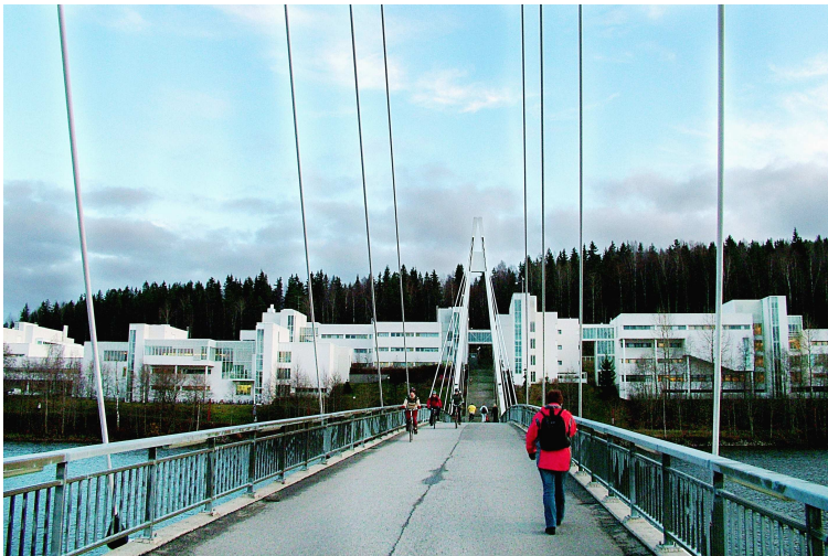
Kuva 1: Jyväsjärven ylittävä kävelysilta yhdistää Ylistönrinteen ja Mattilanniemen kampukset.
