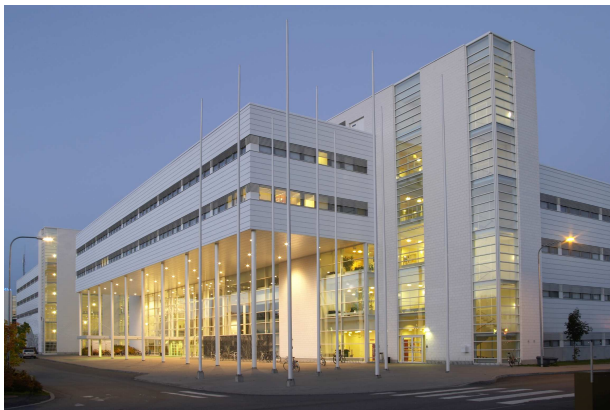
Kuva 2: Tiedekuntamme koti, Agora, on opetuksen, tutkimuksen ja yritysten kohtauspaikka.
