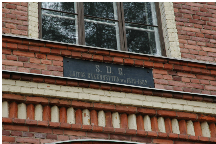
Kuva 1: Jyväskylän yliopiston juuret ovat vuonna 1863 perustetussa Seminaarissa, jolle rakennetut yli sata vuotta vanhat punatiiliset "opin kasarit" ovat edelleen yliopiston käytössä.
