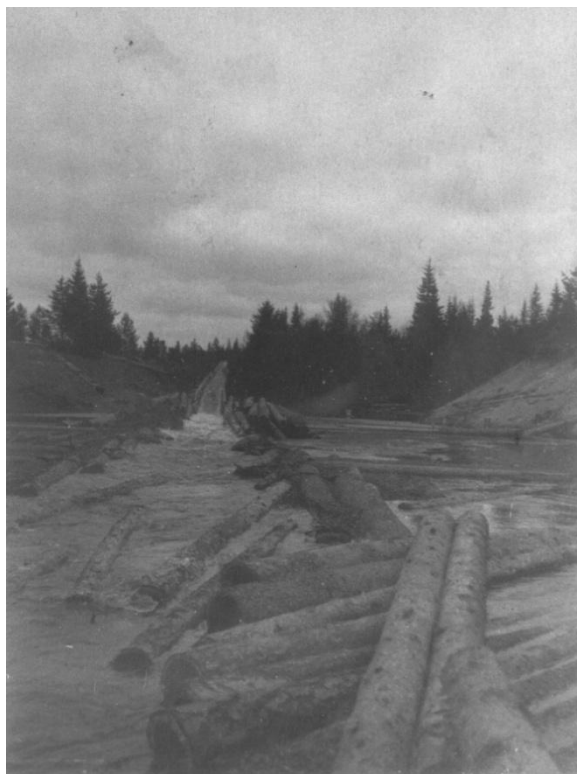
Kirveskanava Kirvesrännin alapuolelta. PK
