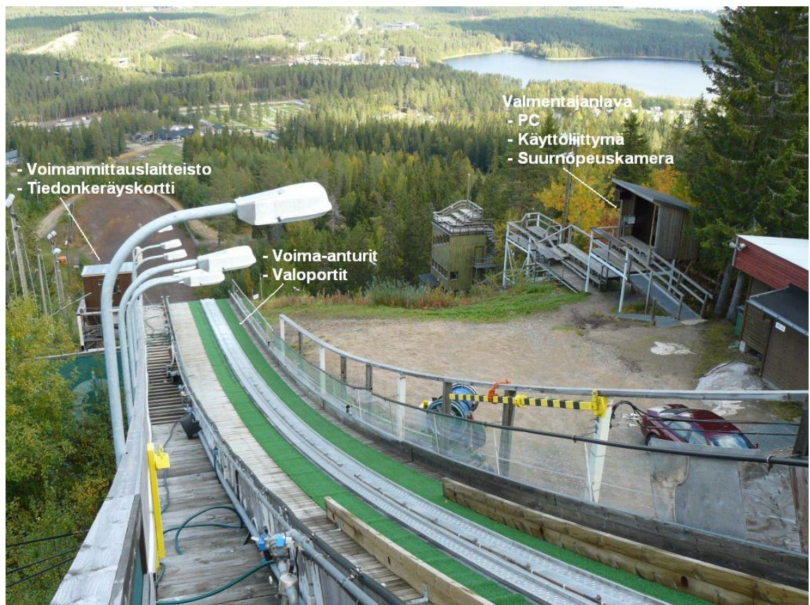
Kuva 6. Vuokatin HS100 hyppyrinmäen palautteenantojärjestelmä
