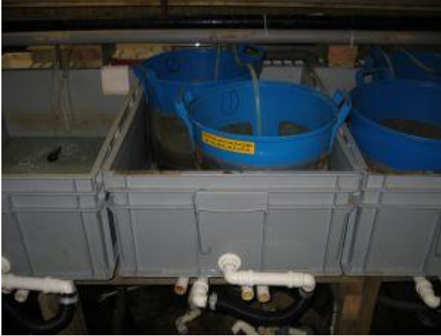
Kuva 1. Mädin haudonnassa käytettyä sihtisaavijärjestelmää.
