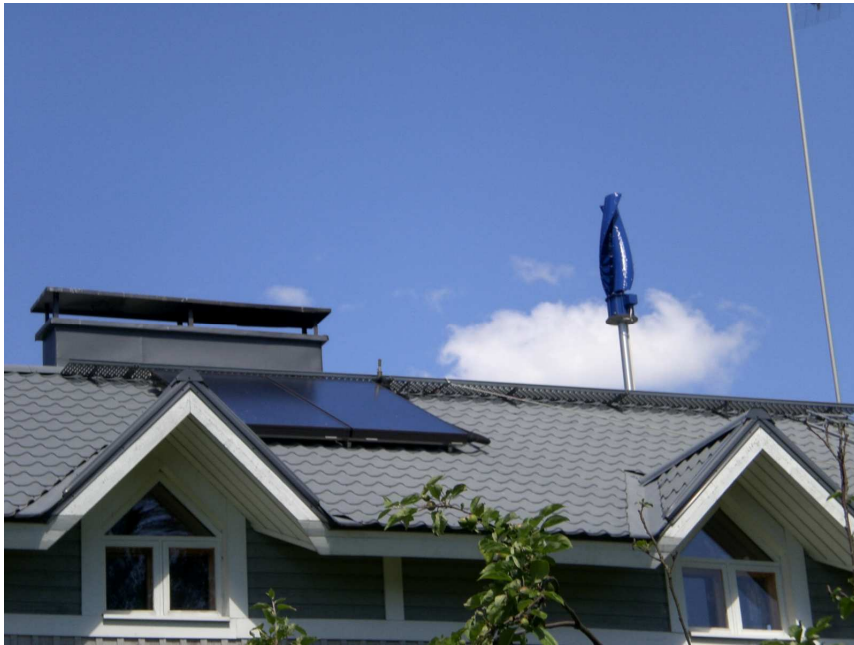
Kuva 6.7. Yhteen liitetyt tasokeräimet. Oikealla näkyy myös tuuliturbiini.
