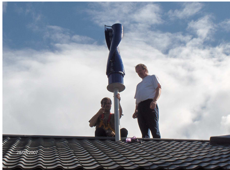
Kuva 6.9. Spiraalimaisen tuuliturbiinin (Windside WS-0,30C) asennusvaihe.
