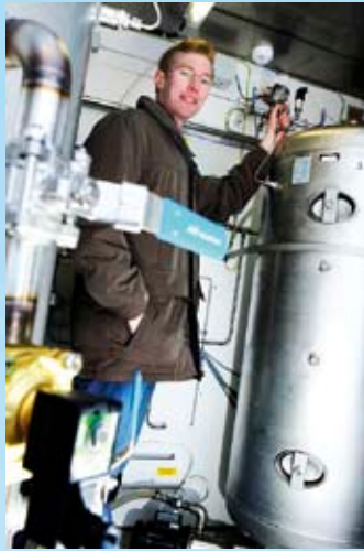
Opiskelija Jussi Läntelä esittelee kaatopaikkakaasun puhdistuslaitteistoon kuuluvaa vedenkäsittelysäiliötä.
