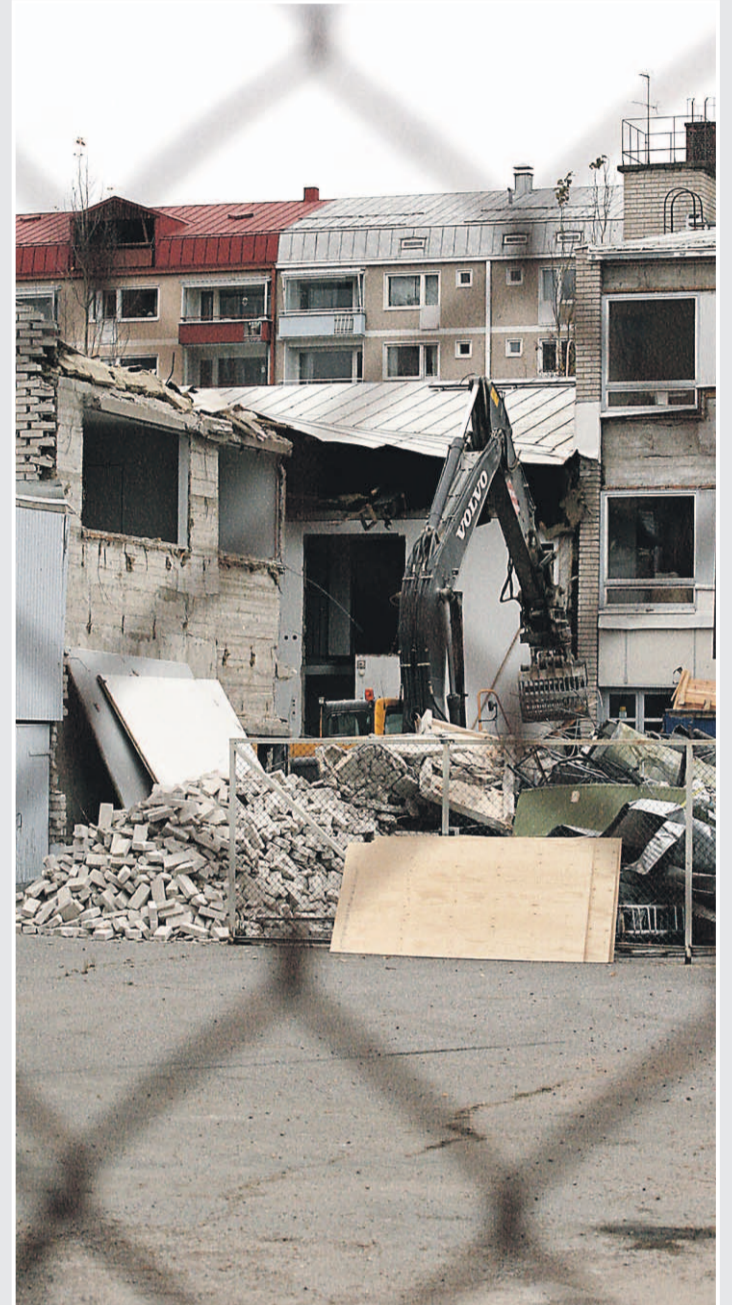
Suuren joukon Jyväskylän yliopiston opiskelijoita kasvattanut Cygnaeus-lukio on muuttunut purkutyömaaksi.
