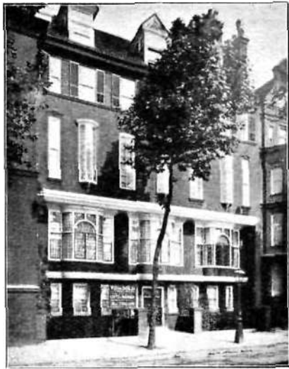
Kuva 7. Asuinrakennus »Old swan house» Chelse'assa Lontoossa. R. Norman Shaw.
