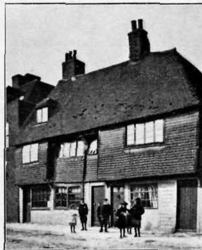
Kuva 2. Vanha talonpoikaistalo tiilikoristuksineen Tenterdenissä, Kentissä.
