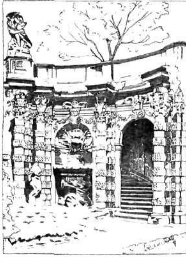
Kuva 37. Terrassi Zwingerissä Dresdenissä.
