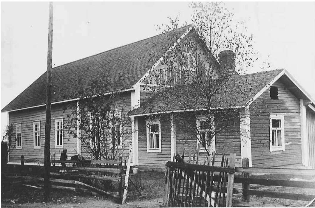
Enon esikoislestadiolaisten rukoushuonetta laajennettiin useita kertoja 1920- ja 1930-luvuilla. Rakennus tuhoutui vuonna 1944 tulipalossa. Kuva: Seppo Leivo
