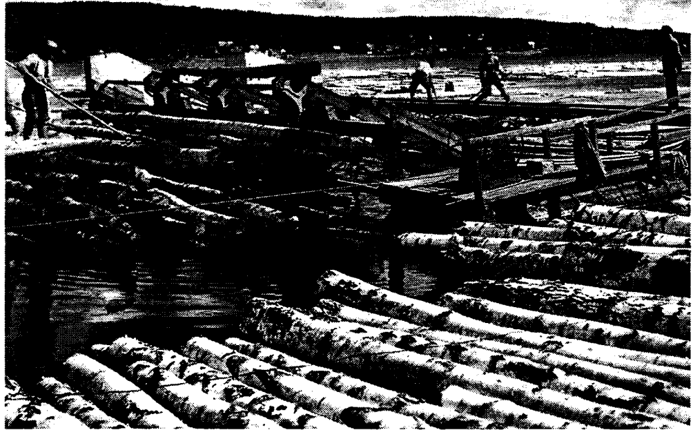
Tehtailla uitetut puut nostettiin joko käsipelin tai erityisen nostolaitteen avulla kuljettimille. Työskentely "transporterilla" kysyi työntekijöiltä melkoisesti kanttia. Kuva Schauman Wood Oy.
