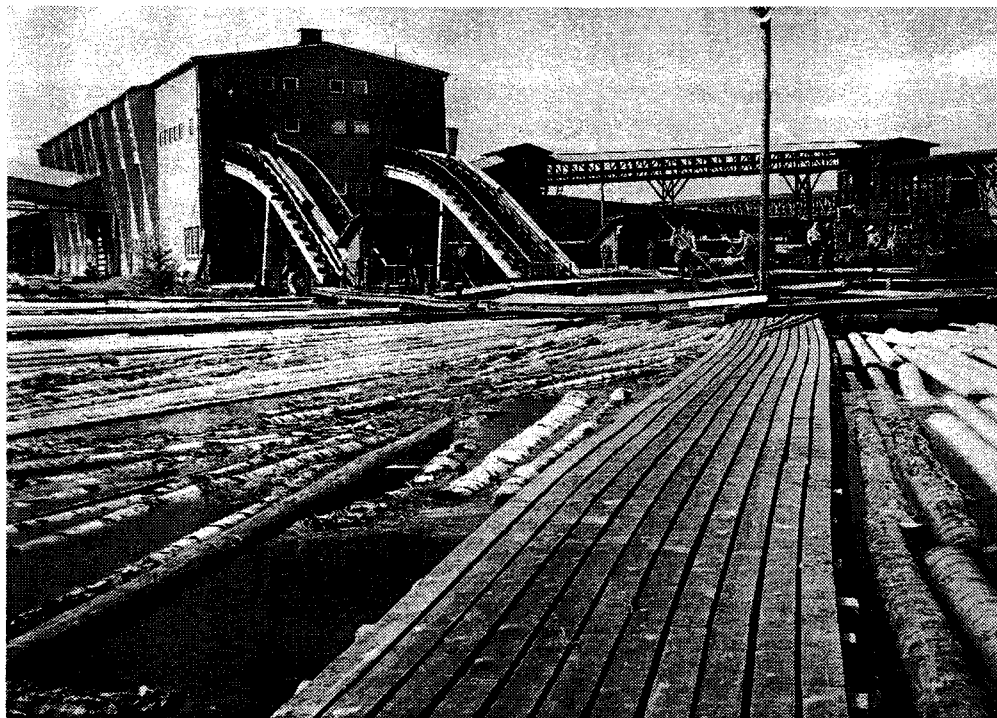
Sotien jälkeen Lutakkoon rakennettiin Suomen ensimmäinen ns. lämmin saha. Etualalla repsikat uittamassa tukkeja luikulta kuljettimelle. Taustalla näkyvät mahattavat hakekuljettimet. Kuva Olavi Helminen.
