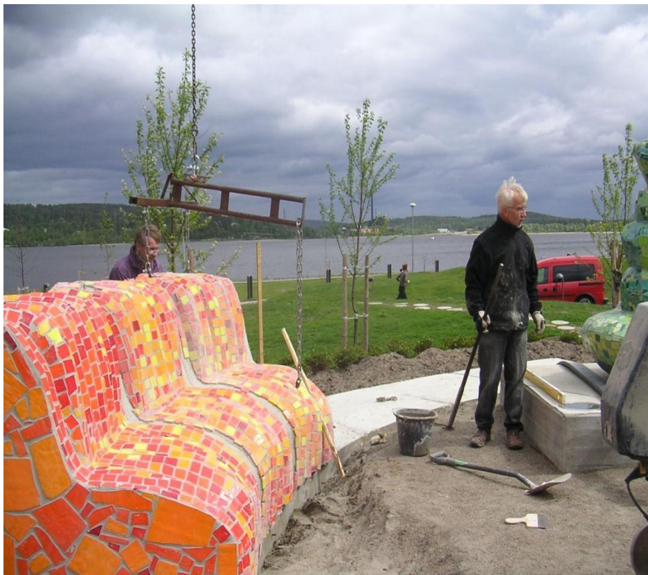
KUVA 13 Rastatukkainen soffa -teoksen kokoaminen ja asentaminen paikalleen, perustukset ja muu rakenne näkyvät hyvin havaintokuvassa. Taidevalaja Jarmo Saarekas asentaa teosta paikalleen (2008). Kuva MK.
