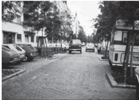
FIGURE 19 Humps in a residential street in Germany ('80); (La città possibile, n.d.).
