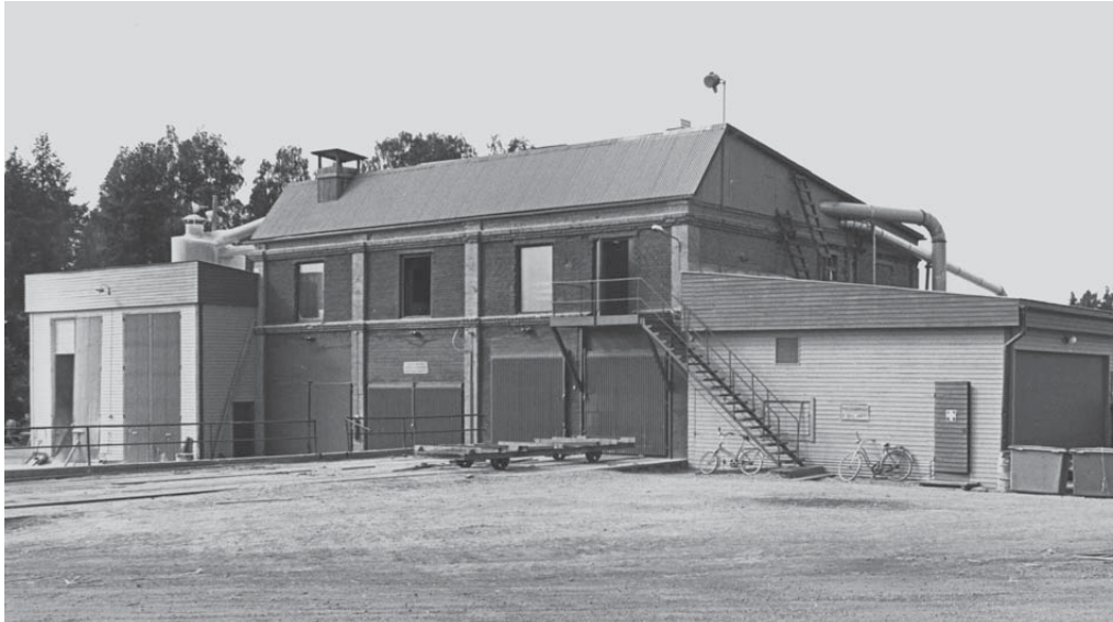
Kettulan sahan höyläämö ja kamarikuivaamot. Aikaisemmin rakennuksessa oli toiminut lämpövoimala. 1960-luvulla puutavaraa kuivattiin monin eri tavoin: kamarikuivaamoissa, tapuleissa sekä sahojen laivauksen yhteiskuivaamolla Paraisilla.
