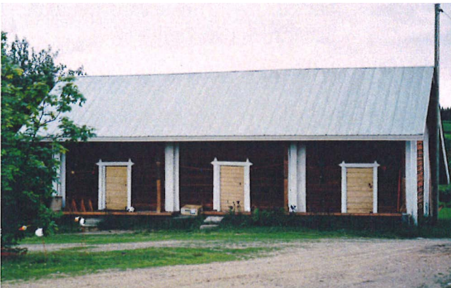
30. Räsälän pihapiirin aittarakenmus. Nukuin keskimmäisessä aitas- sa erittäin hyvin päivän heinätyön ja saunan jälkeen.
