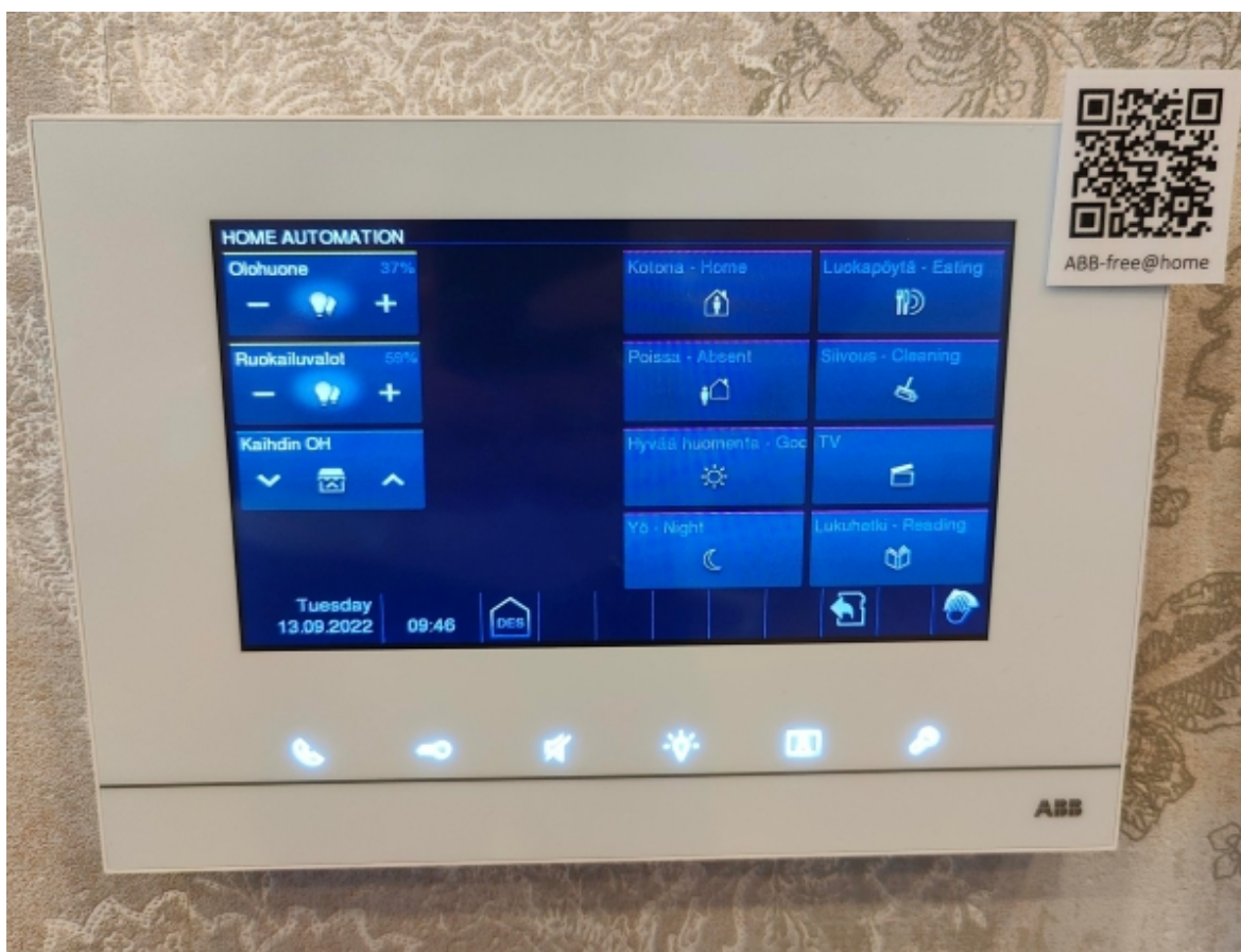
Kuva 4.4: ABB Free@home kiinteistöautomaatiojärjestelmän ohjauspaneeli.
