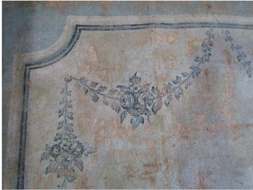
Kuva 10. Pellava- tai hamppukankaalle öljymaalilla maalattu tapetti, jossa on ajalle tyypillisiä symmetrisiä kukkakuvioita. Valmistettu 1790-luvulla. Lähde: Turun museokeskus.
