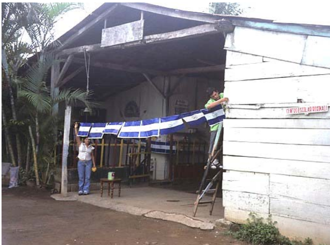
Kuva 9. Roxikalin koulun rakennus.
