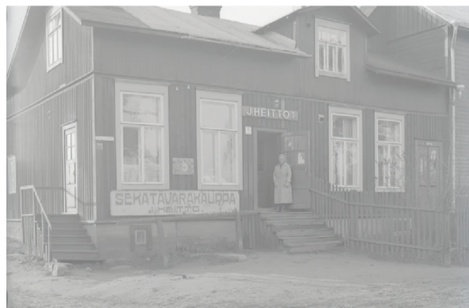
Sekatavara- ja maitokauppa J. Heiton myymälärakennus Viipurin Pyöräsuolla Kannaksentiellä 1930-luvulla. Kuva: Mauno Mannelin. Etelä-Karjalan museo.
