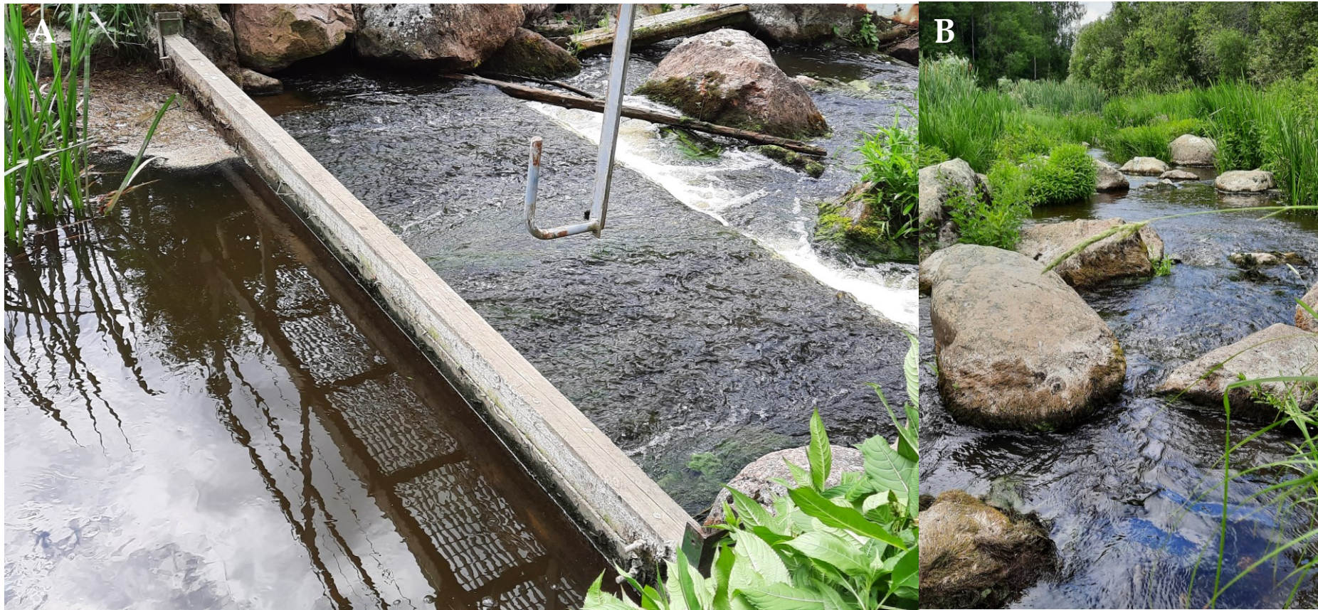
Kuva 10. A) Strömsbergin ohitusuoman yläpään settipatorakenne. B) Strömsbergin ohitusuoma.
