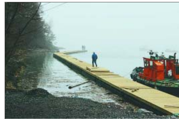
Ponttonilaituri rakennettiin yksityisen rannan eteen ilman maanomistajan lupaa.
