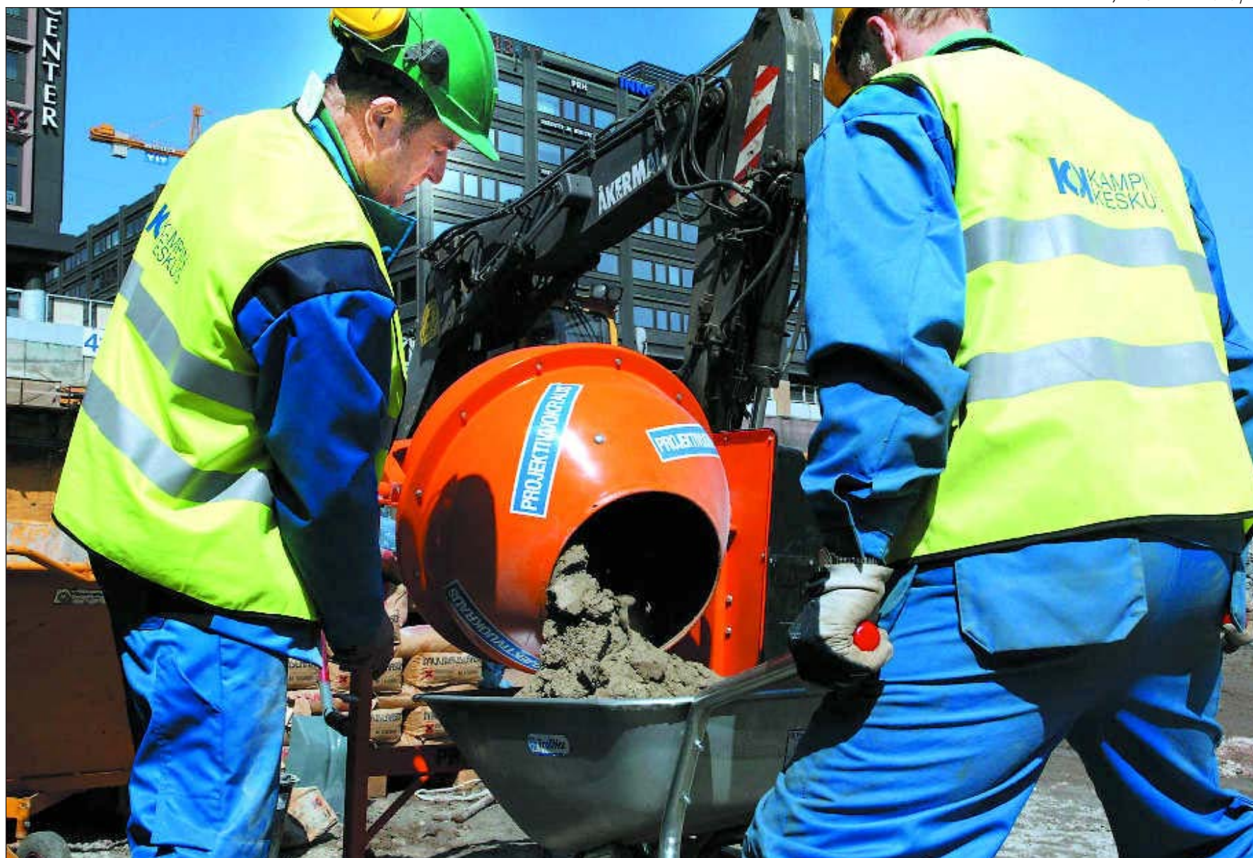
Teuvo Teurokoski (vas) ja Matti Backman väänivät eilen Kampin työmaalla betonilaastia Kampin keskuksen peruskiven muuranneelle Anneli Jäätteenmäelle.
