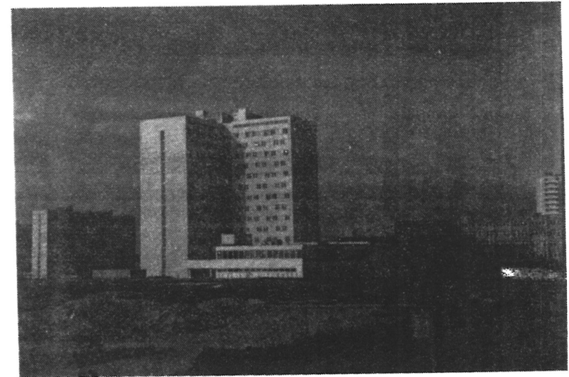
Puškin-instituutin asuntola, joka on tarkoitettu lähinnä ulkomaalaisille venäjän kielen opiskelijoille ja opettajille. Oikealla on valmistumassa oleva varsinainen instituutin päärakennus, johon tulevat tutkijoiden työhuoneet ja kaikki opetustilat. Puškin-instituutti on laitos, joka on erikoistunut venäjää vieraana kielenä opettavien jatkokoulutukseen sekä venäjän kielen opetuksen tutkimukseen. Haastateltavamme A.A. Leontjev työskentelee tässä laitoksessa.
